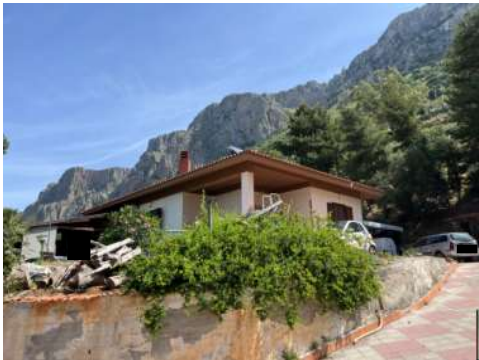
Foto 2 vista prospettica fabbricato
