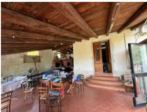
Foto 6 copertura in legno porticato esterno-
