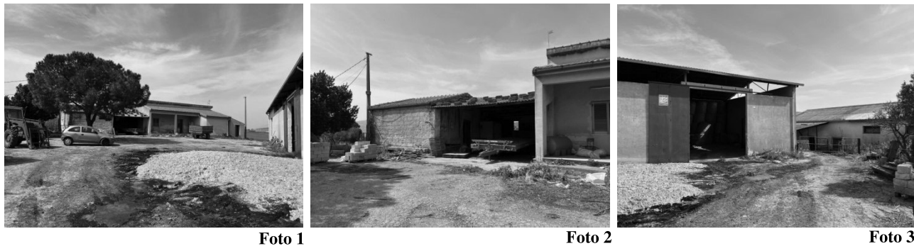
Corpo A (sub. 7) - Destinato ad abitazione a servizio dei lavoratori dell’azienda, trattasi di un immobile ad
