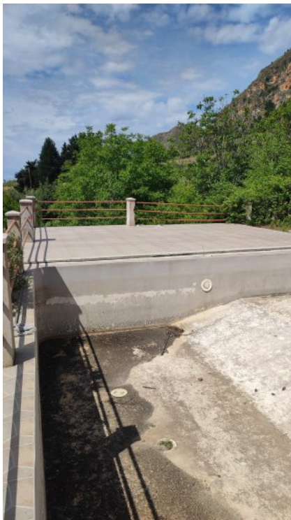
Foto n. 7 – Particolare piscina e copertura magazzino
