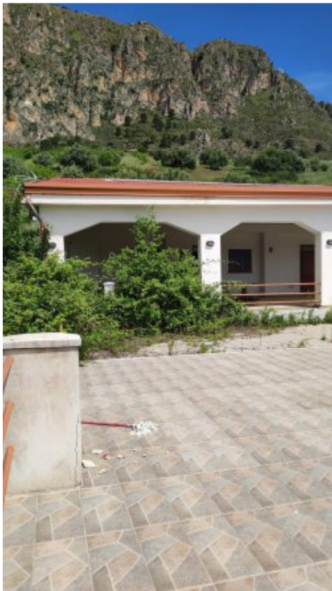
Foto n. 1 – Prospetto principale del corpo di fabbrica
