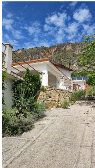
Foto n. 4 – Scivolo di accesso
