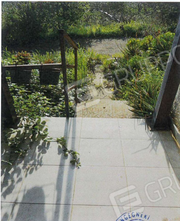
Ingresso struttura prefabbricata
