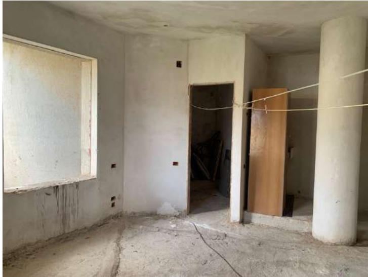
Foto n. 7 – Interno villa: piano primo incompleto
