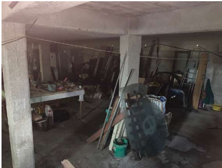
Foto n. 8 – Interno villa: piano seminterrato incompleto
