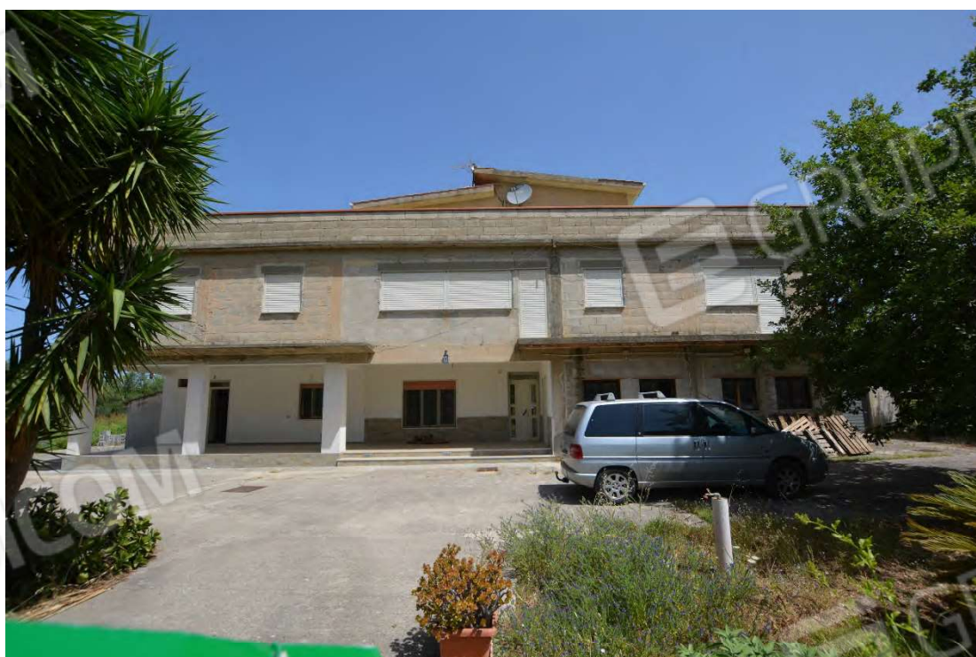
Foto 1 – Ingresso complesso immobiliare di C.da Albachiera snc a Partinico (PA)
