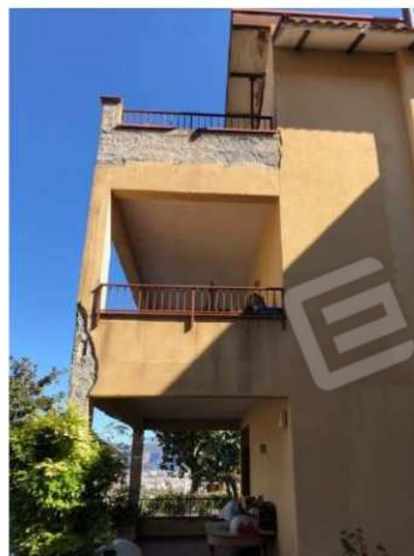
ammaloramenti sotto balconi, pilastri e
