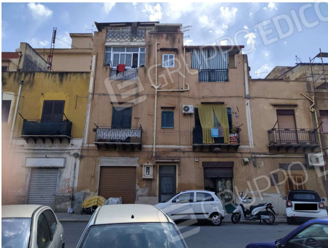
Vista del fabbricato sulla via Brancaccio (F.1)
