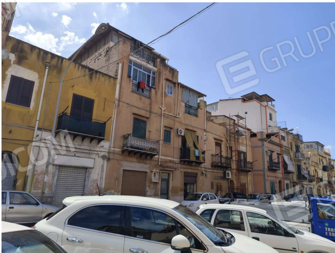
Vista del fabbricato sulla via Brancaccio (F.2)
