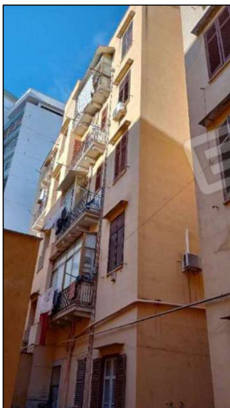
Foto 3 – portone d'accesso civ. 135 Corso dei Mille Foto 4 – accesso scala B condominiale dal cortile
