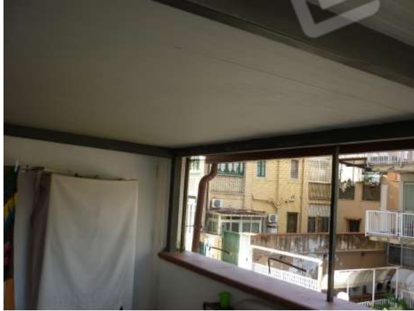
Foto n. 13 – Tettoia con pannelli coibentati
