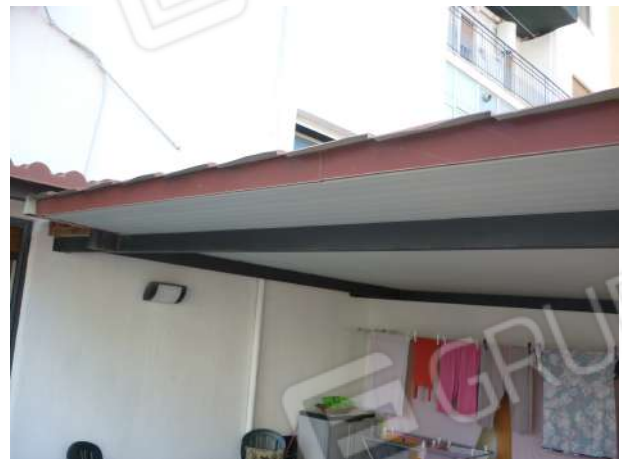
Foto n. 12 – Tettoia con pannelli coibentati
