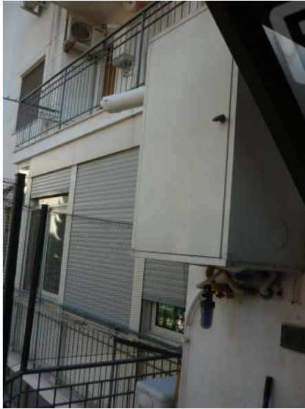
Foto n. 5 – Infissi veranda e caldaia
