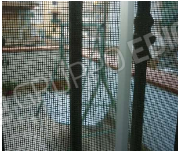
Foto n. 10 – Infisso e cancello di protezione verso la terrazza
