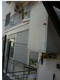
Foto 5 – Infissi esterni veranda
