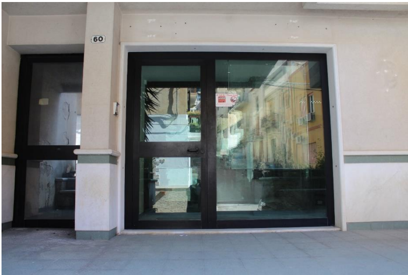
Vista dell'ingresso su corte comune
