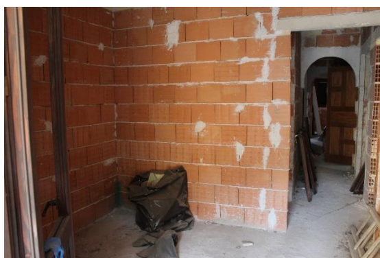
Vista di futuro vano
