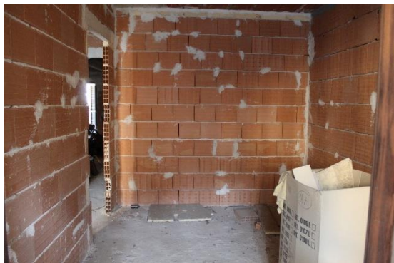
Vista di futuro vano
