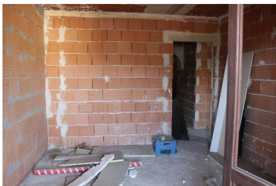
Vista di futuro vano
