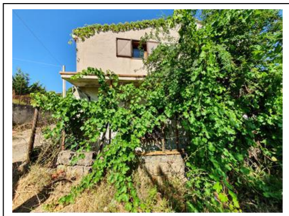
Foto 3 – Vista fronte est
