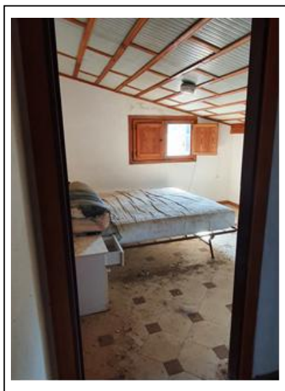
Foto 16– vano 3 piano primo
