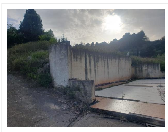
Foto n. 5 Muro di sostegno e platea in c.a
