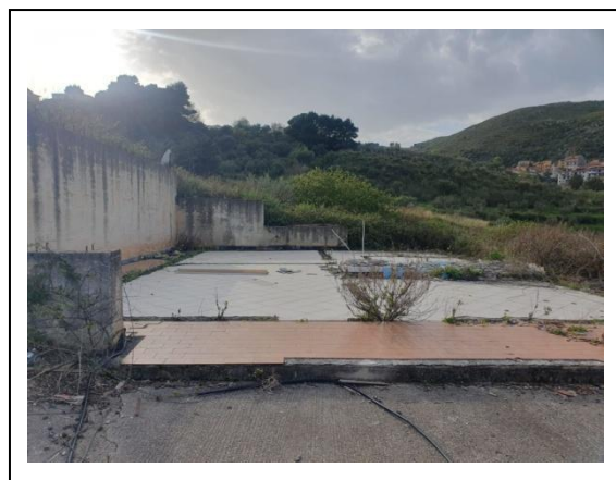
Foto n. 6 Muro di sostegno e platea in c.a
