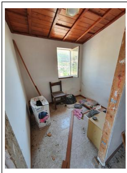
Foto 14 – vano 2 piano primo
