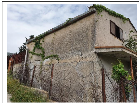
Foto 2 – Vista fronte sud
