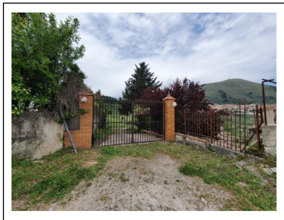
Foto n. 1 Cancelli di ingresso al lotto
