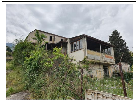
Foto 1 – Vista fronte nord
