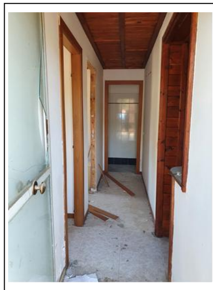
Foto 12 – corridoio di disimpegno
