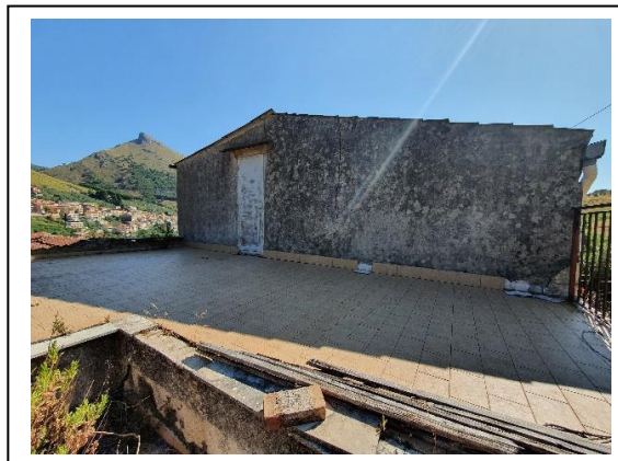
Foto 6- ingresso al fabbricato dalla terrazza al piano primo
