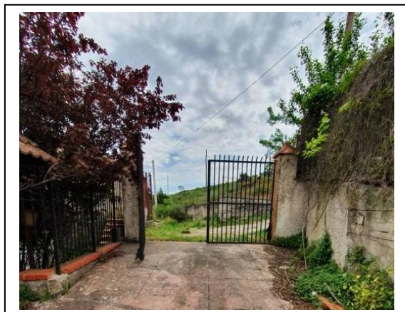
Foto n. 2 Cancelli di ingresso visto dalla strada all'interno del lotto
