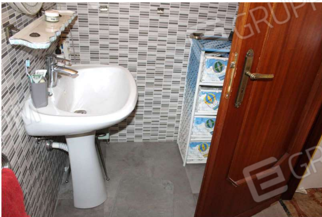
FOTO n°26: W.c. senza luce (Vano 6).
