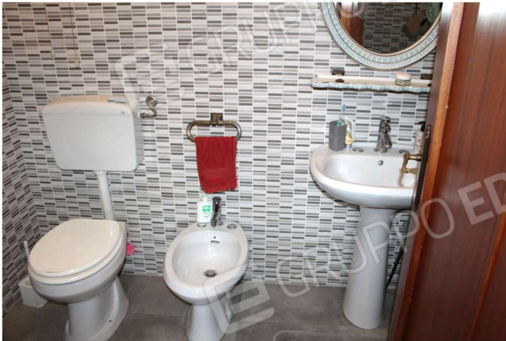
FOTO n°25: W.c. senza luce (Vano 6).
