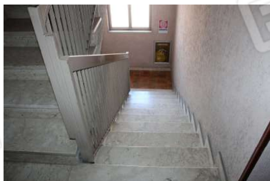
FOTO n°7: Vano scala condominiale
