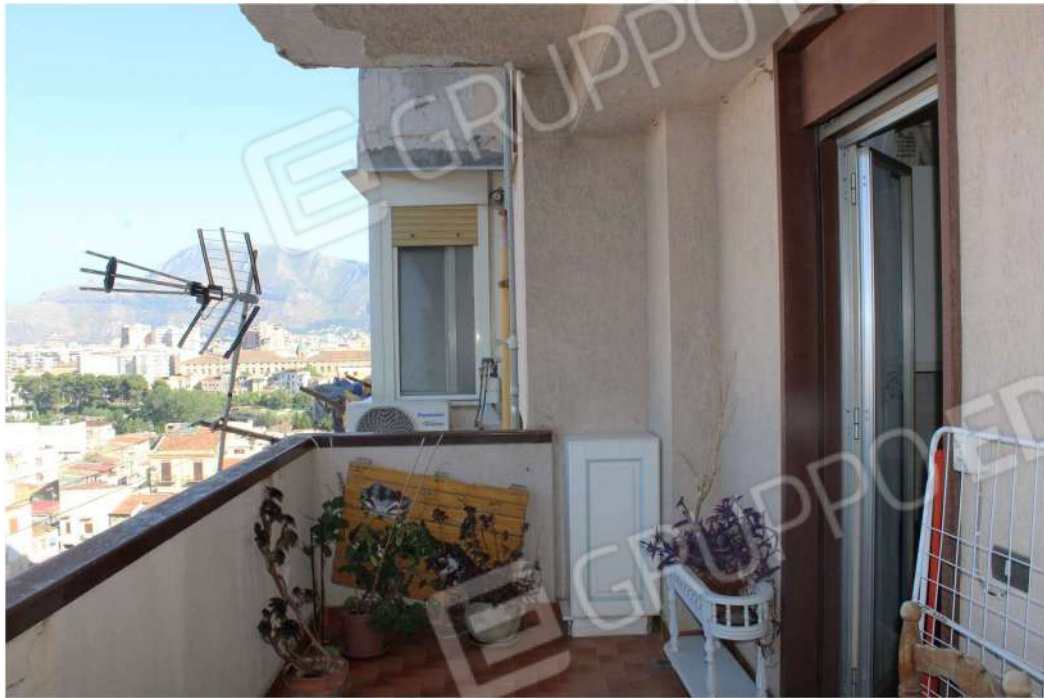
FOTO n°14: Balcone con accesso dal vano 2 (Balcone "B").
