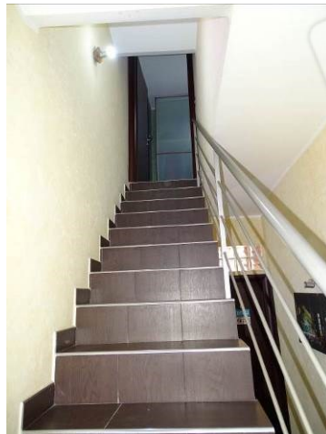
Foto n. 24 P.2 - Scala interna
