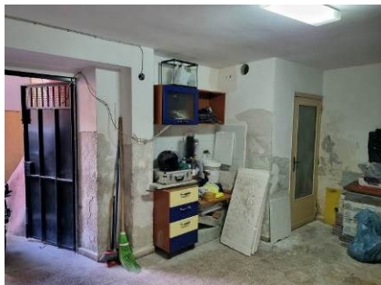
Foto n. 38 Piano Terra - Locale Box.
