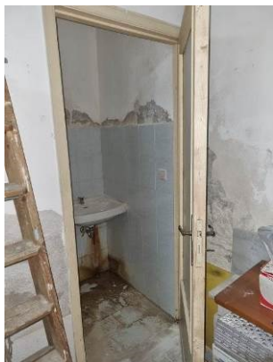
Foto n. 41 P.T. - Locale wc nel Locale Box.
