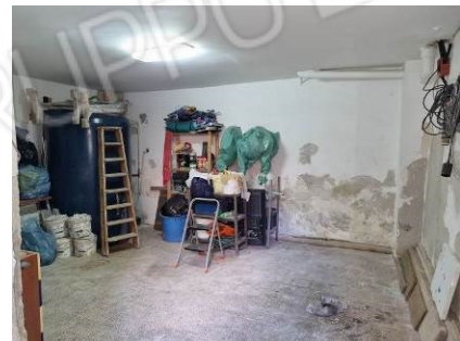
Foto n. 40 P.T. - Locale Box.
