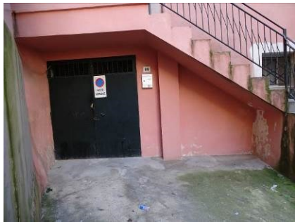
Foto n. 35 Piano Terra - Locale Box.
