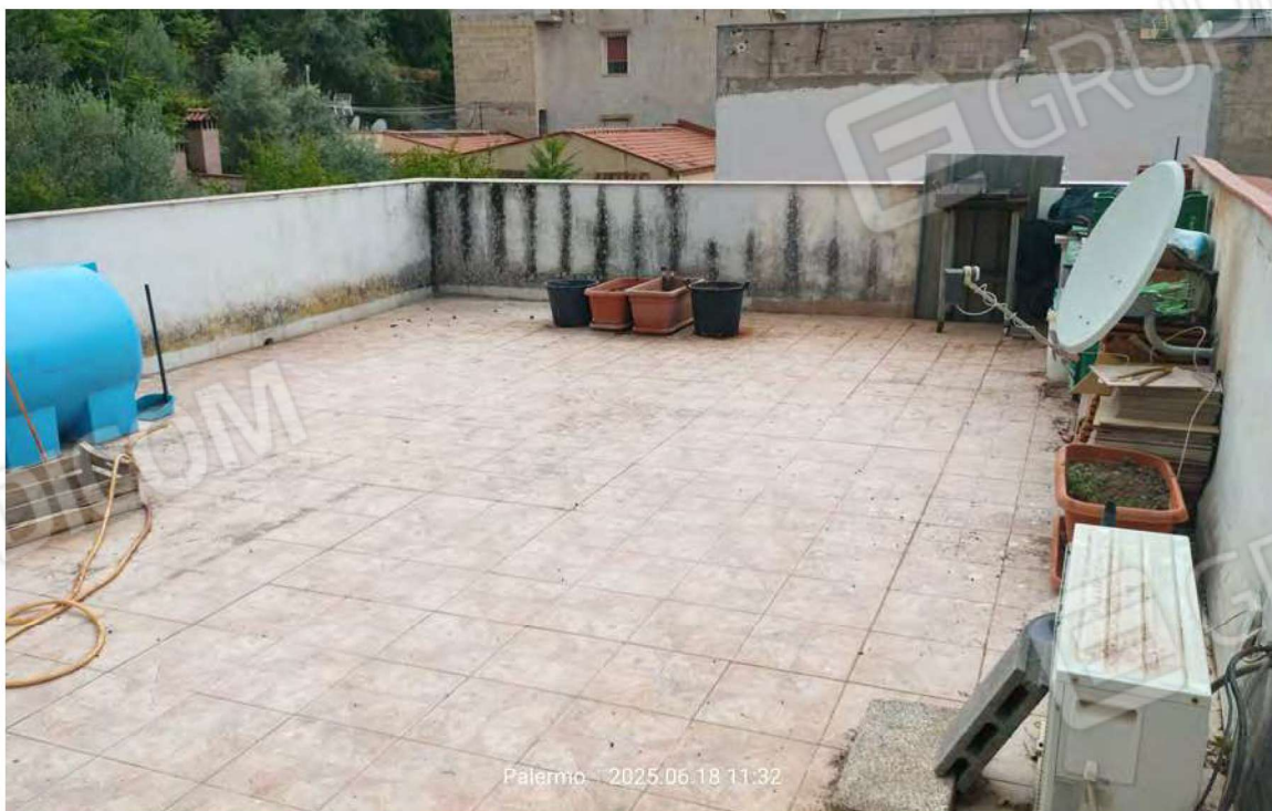
Foto 20 - Vista lastrico solare
