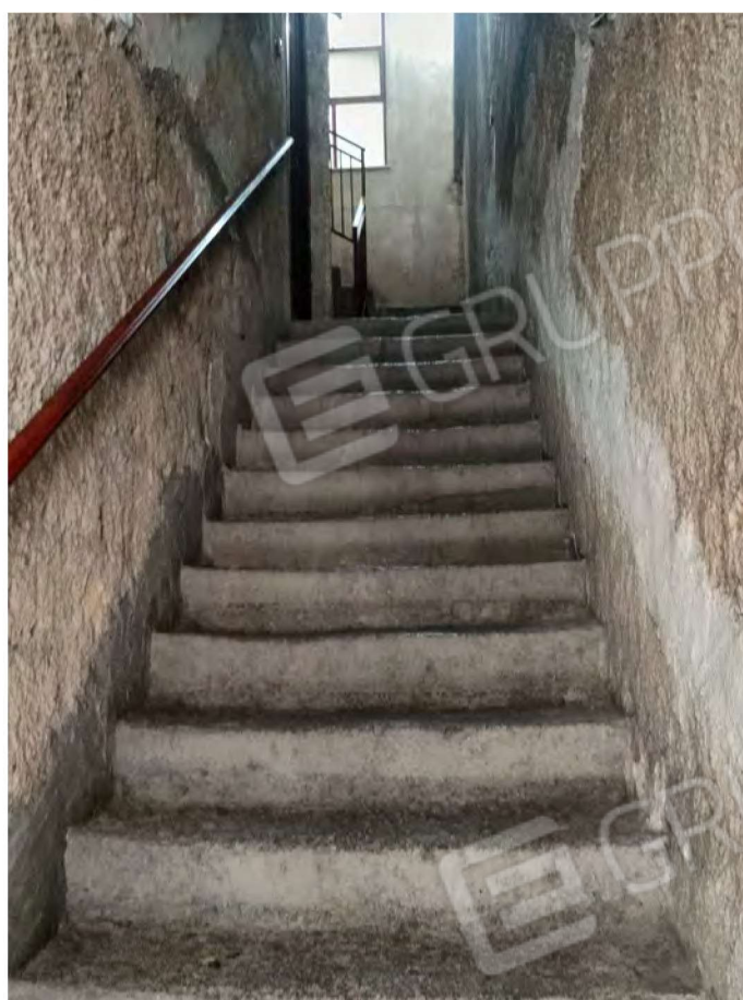
Foto 4 - Vista vano scala
