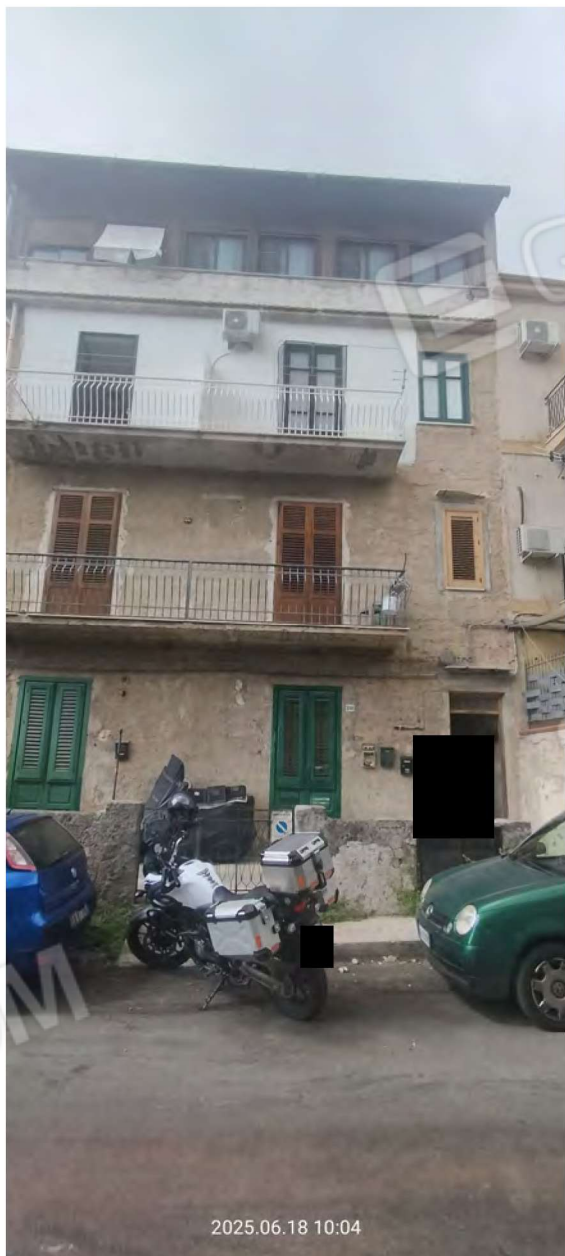
Foto 1- Vista prospetto da via San Martino
