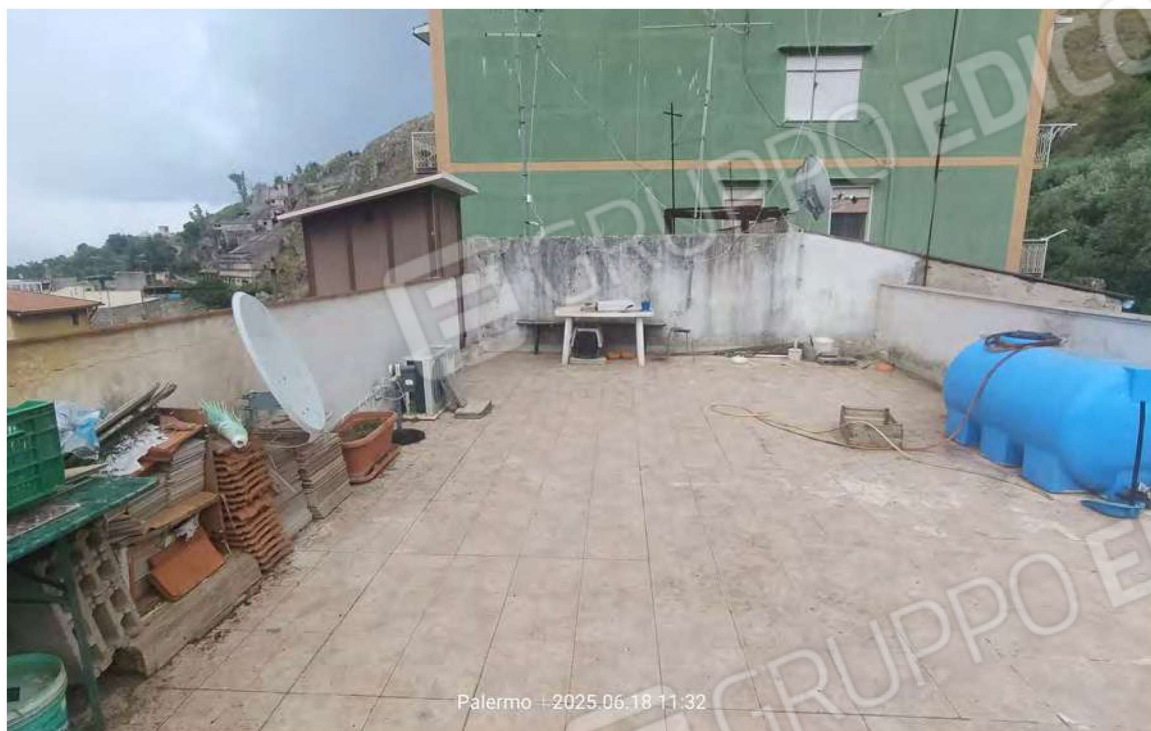
Foto 21 – Vista lastrico solare
