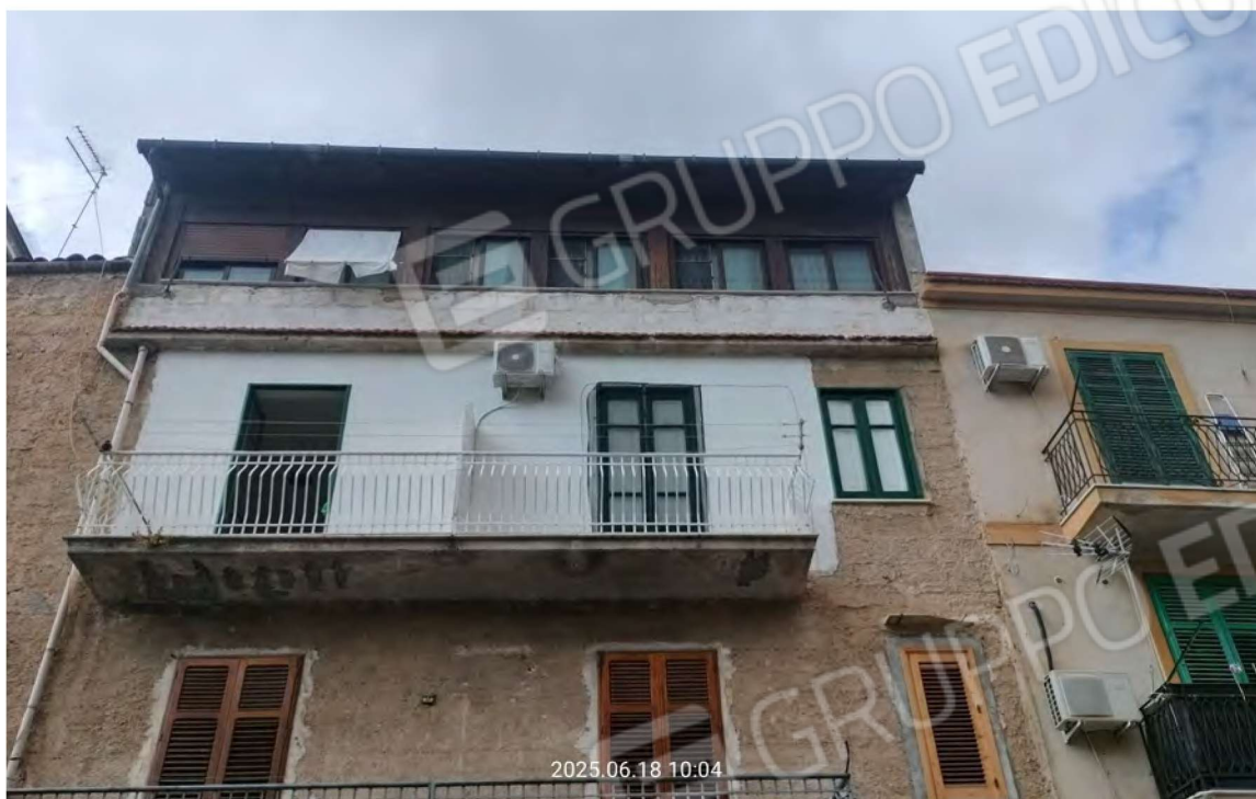
Foto 3 - Vista veranda immobile
