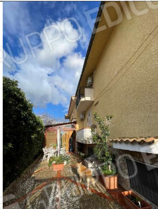
Cortile di ingresso su sub 3
