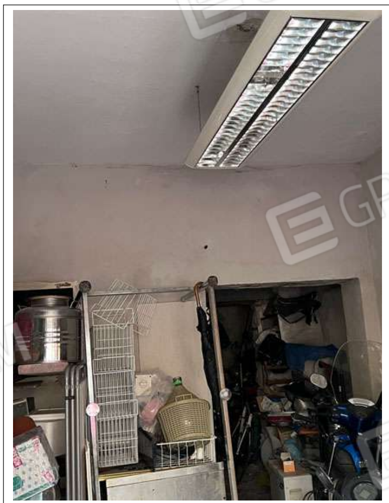
Foto n. 2-3. Vano di ingresso dell'immobile
