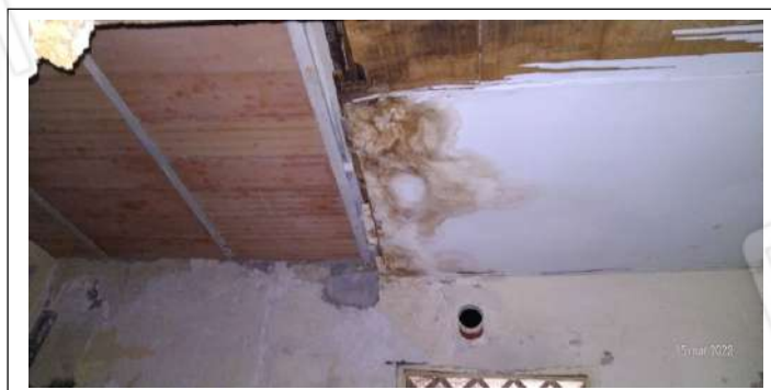
Foto n. 9. Vano prospettante sulla chiostrina interna al fabbricato. Soffitto in cui è stata parzialmente sostituita la vecchia struttura in legno con una in profili di acciaio e laterizi
