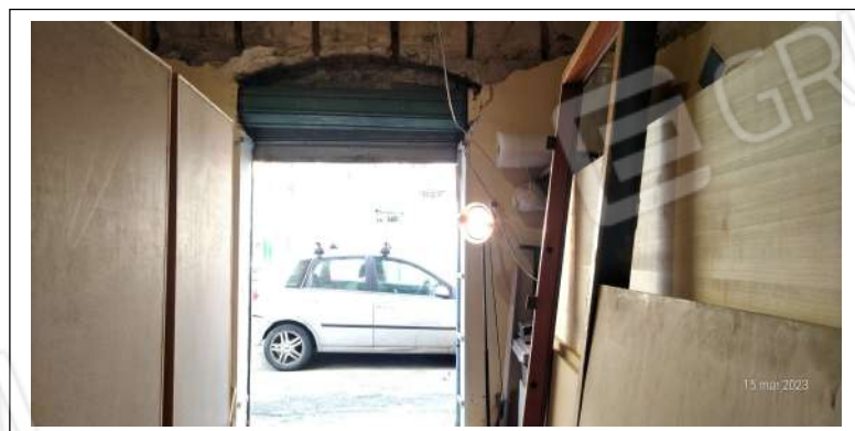
Foto n. 6. Interno del magazzino identificato al sub. 11.
