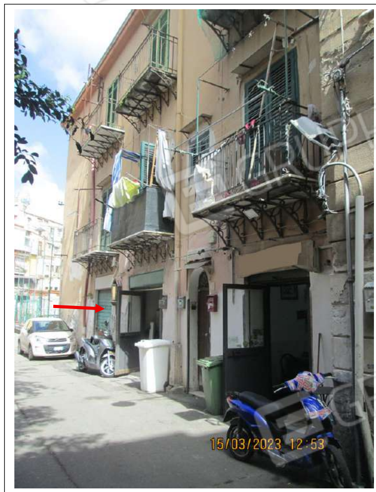
Foto n. 2. Ingresso al magazzino identificato al sub. 12 da Vicolo II del Celso n. 11, indicato con la freccia rossa
