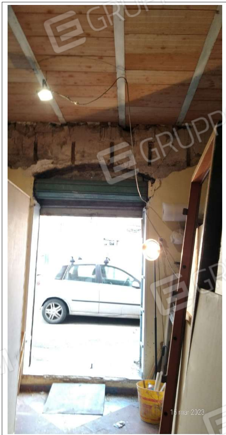
Foto n. 7. Interno del magazzino identificato al sub. 11.
