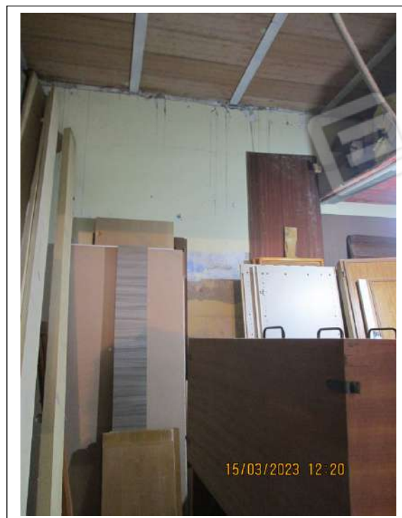
Foto n. 10 -11. Interno del magazzino identificato al sub. 12.
