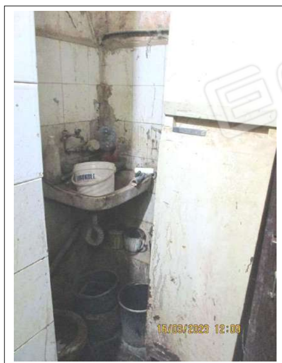
Foto n. 14. Piccolo servizio igienico ricavato nello spazio sottoscala di maggiore altezza
