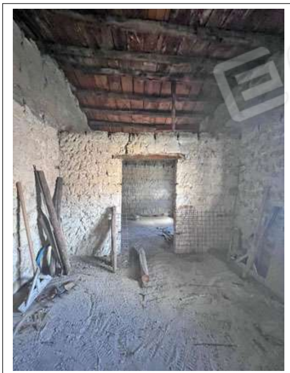
Foto n. 26. Immobile identificato al sub. 16. Apertura di collegamento tra i vani prospettanti su Piazza Linares
