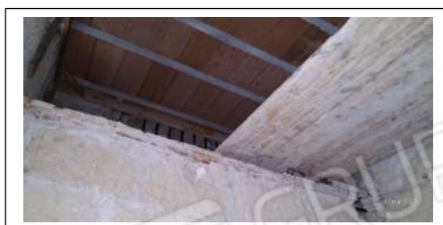
Foto n. 19-20. Immobile identificato al sub. 13. Soppalco/ripostiglio del vano indicato come cucina nella planimetria catastale di impianto
