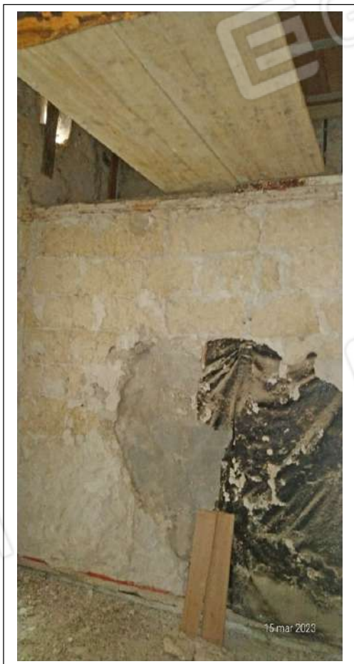
Foto n. 18. Immobile identificato al sub. 13. Vano con soppalco/ripostiglio indicato come cucina nella planimetria catastale di impianto
