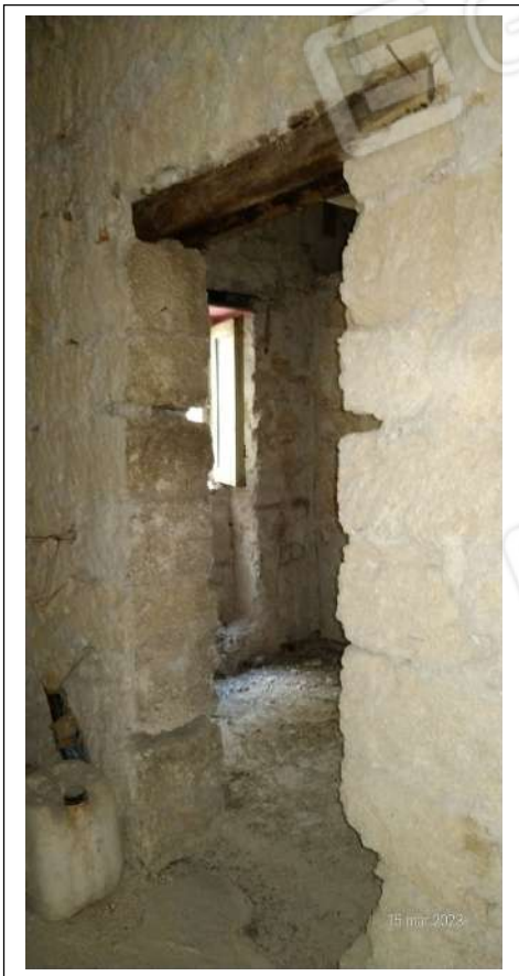
Foto n. 16. Immobile identificato al sub. 13. Apertura di collegamento tra l'ambiente di ingresso e il vano indicato come cucina nella planimetria catastale di impianto
