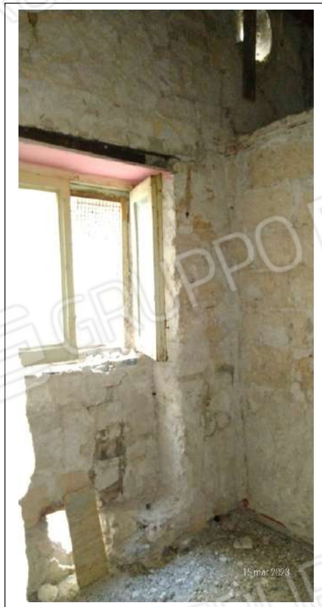
Foto n. 17. Immobile identificato al sub. 13. Vano con soppalco/ripostiglio indicato come cucina nella planimetria catastale di impianto
