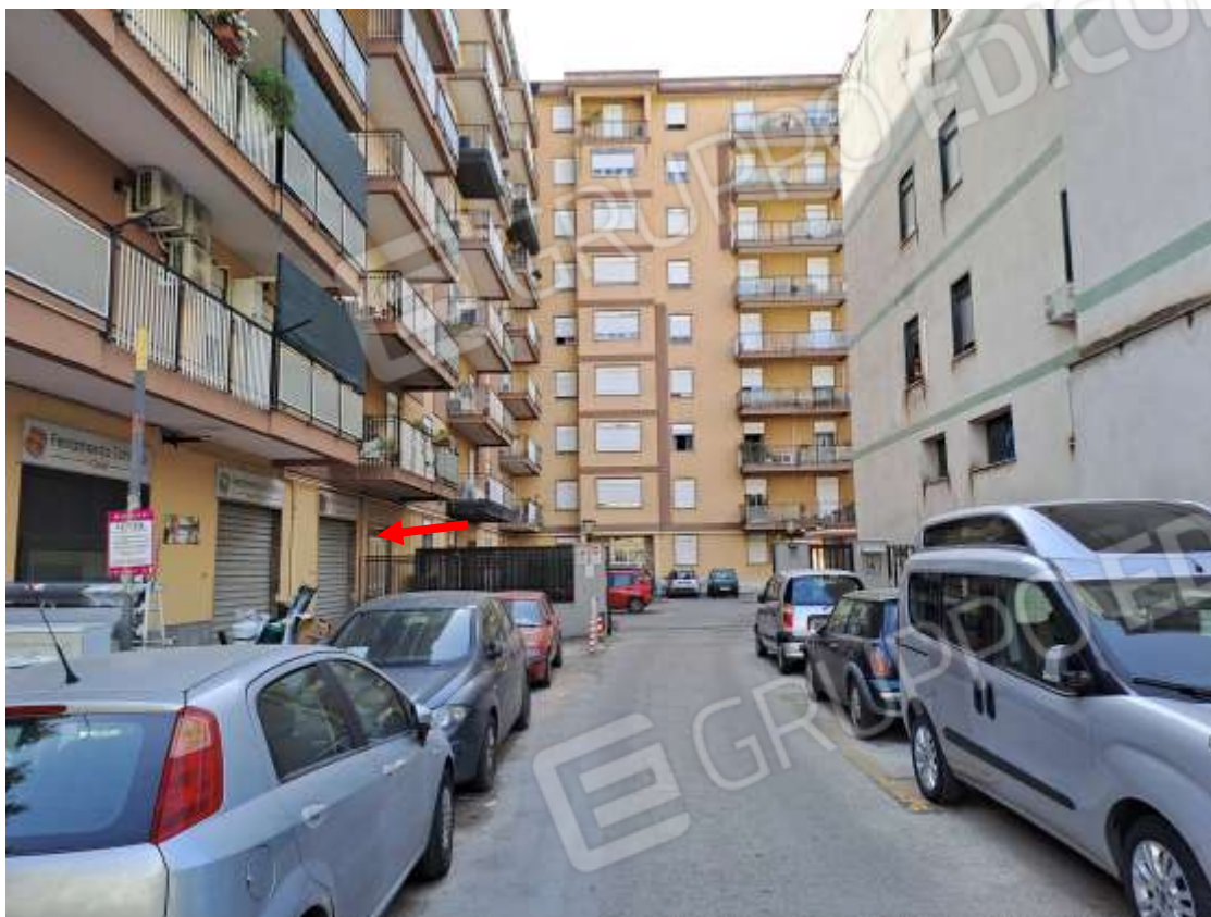
Foto n. 3 – Vista da Via Palmerino dell'accesso al complesso condominiale sito in Palermo, Via Palmerino n. 42.
