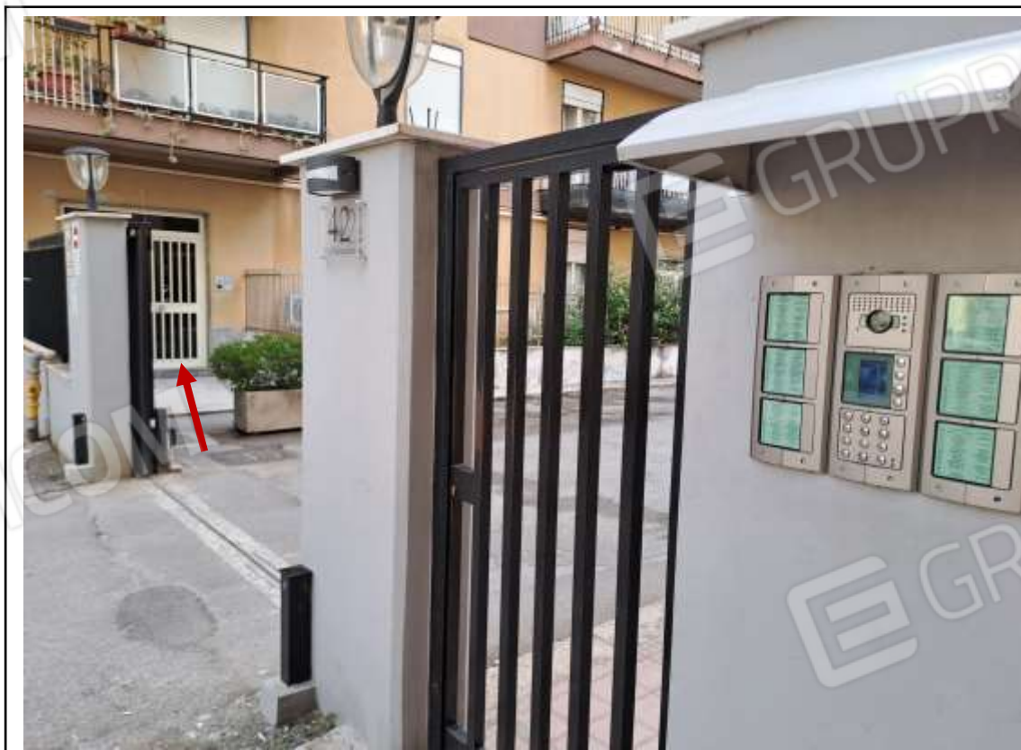
Foto n. 4 – Vista da Via Palmerino dell'accesso al complesso condominiale sito in Palermo, Via Palmerino n. 42 e dell'accesso all'edificio (v. freccia) ove è ubicato l'appartamento.
