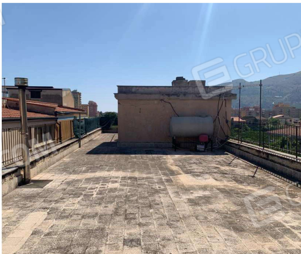
Foto n. 25 - Lastrico solare di copertura e torrino scala
