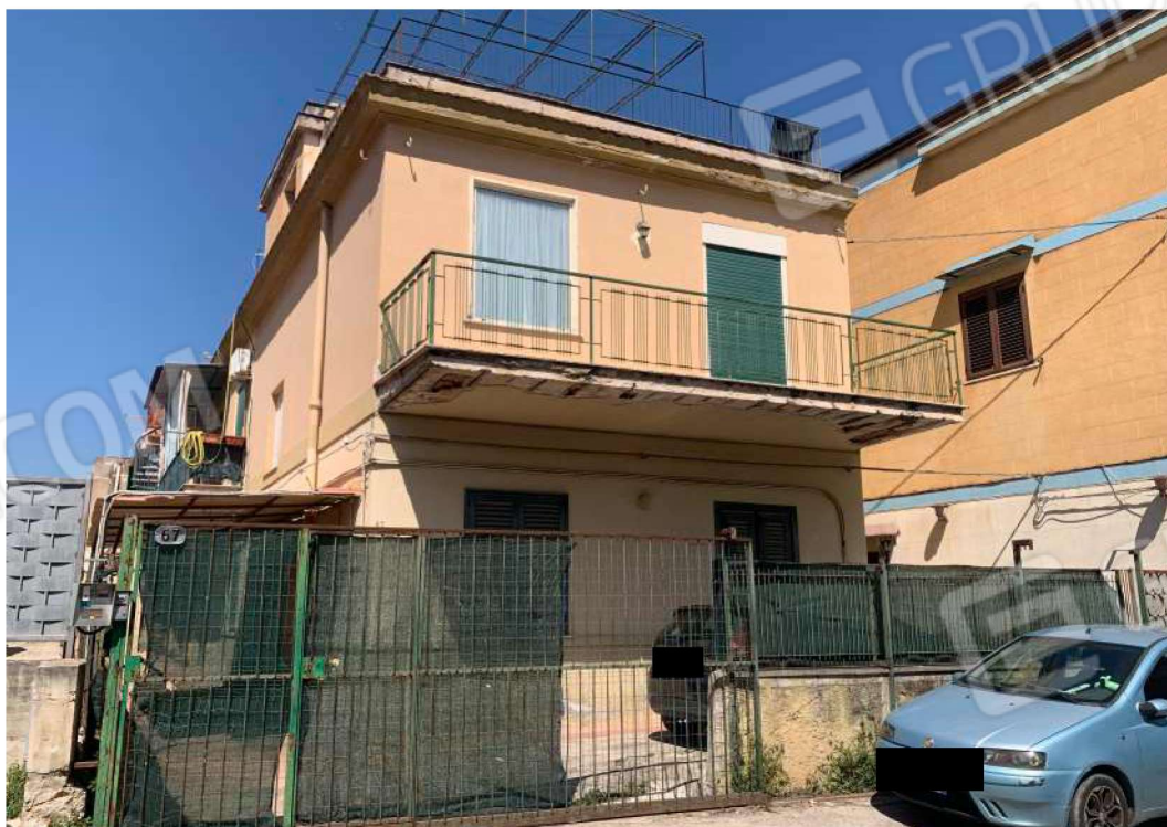
Foto n. 3 - Prospetto su via Aloï
