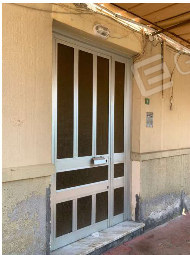
Foto n. 7 - Portone d'ingresso all'edificio
