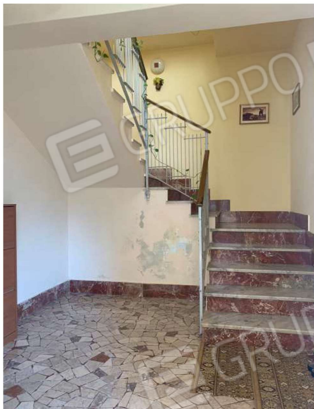
Foto n. 8 - Androne e corpo scala condominiali
