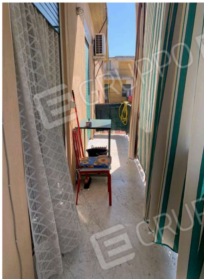
Foto n. 22 - Balcone su prospetto laterale
