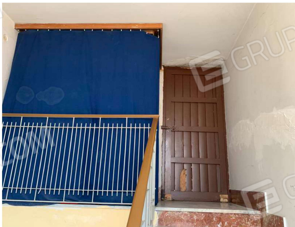
Foto n. 23 - Accesso al lastrico solare di copertura
