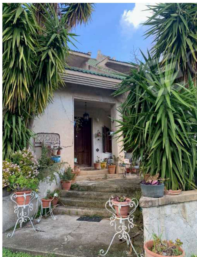
Foto n. 16 - Villa alla particella 726
