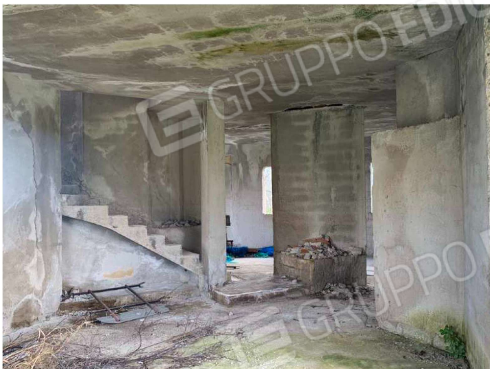
Foto n. 5 - Rudere alla particella 770
