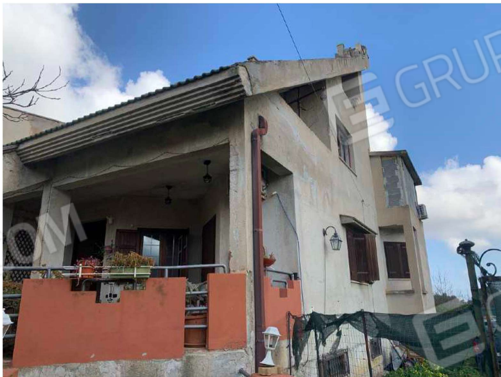
Foto n. 12 - Villa alla particella 726
