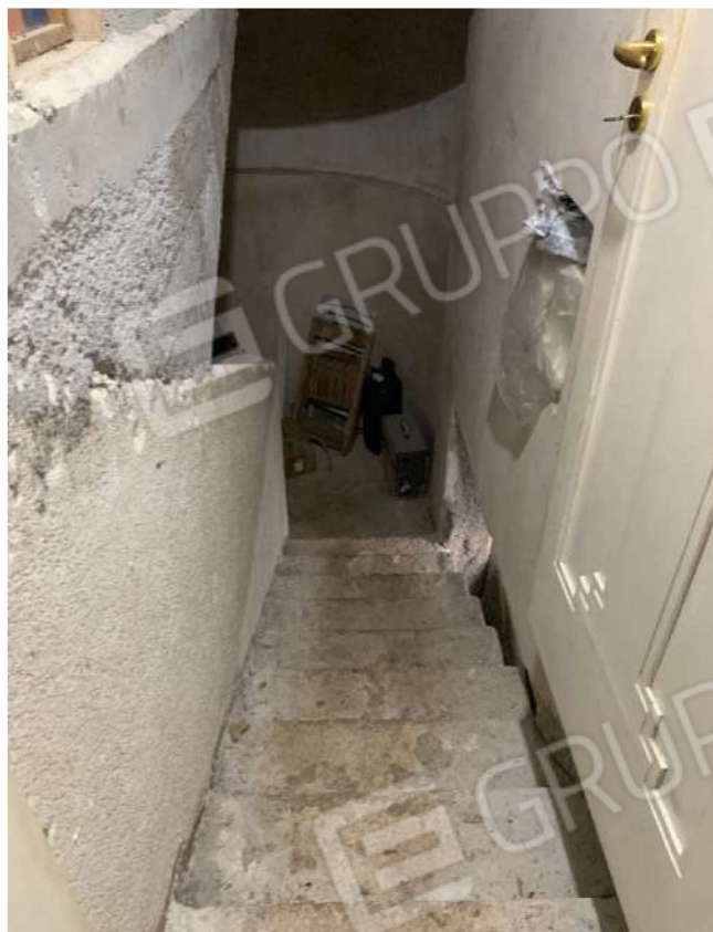
Foto n. 33 - Villa alla particella 726: scale verso la cantina
