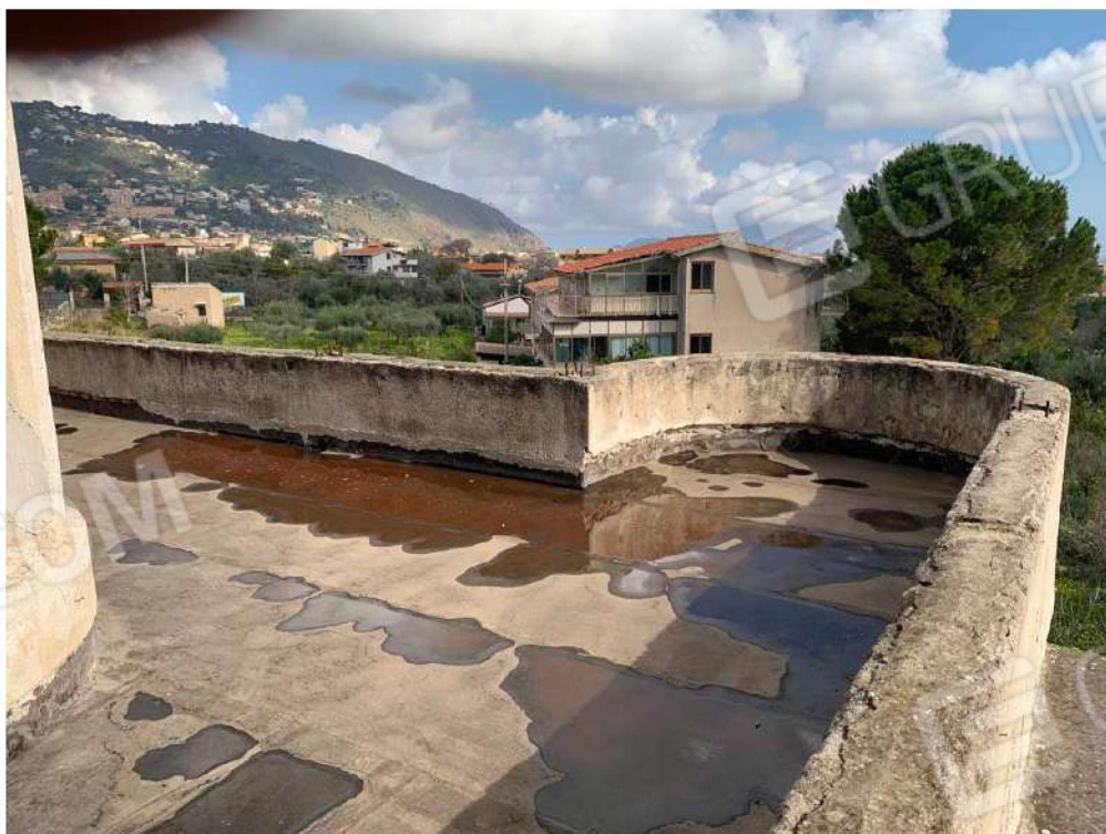
Foto n. 30 - Villa alla particella 726: Terrazzo
