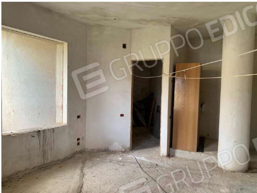
Foto n. 27 - Villa alla particella 726: Piano Primo
