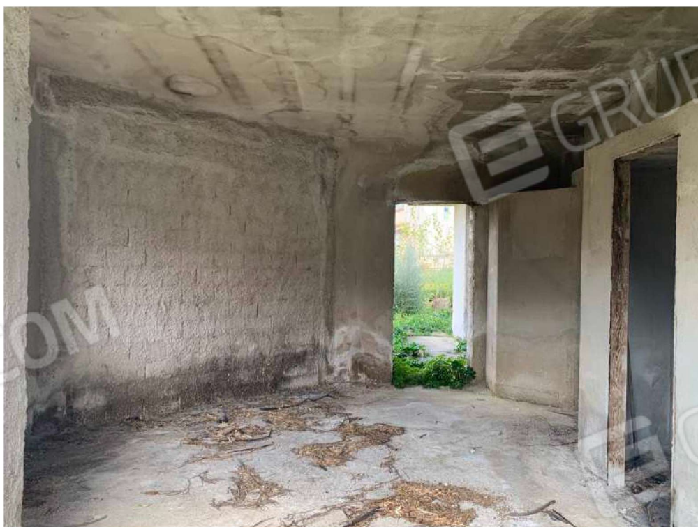
Foto n. 6 - Rudere alla particella 770
