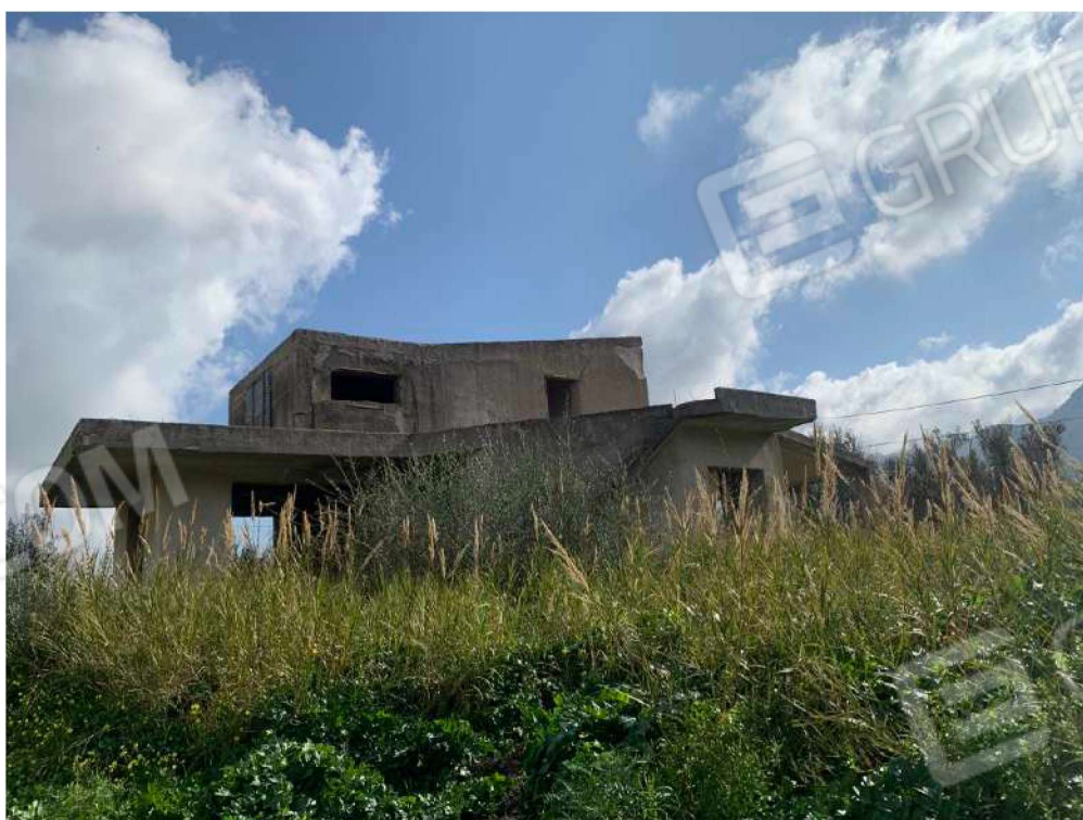
Foto n. 8 - Rudere alla particella 770
