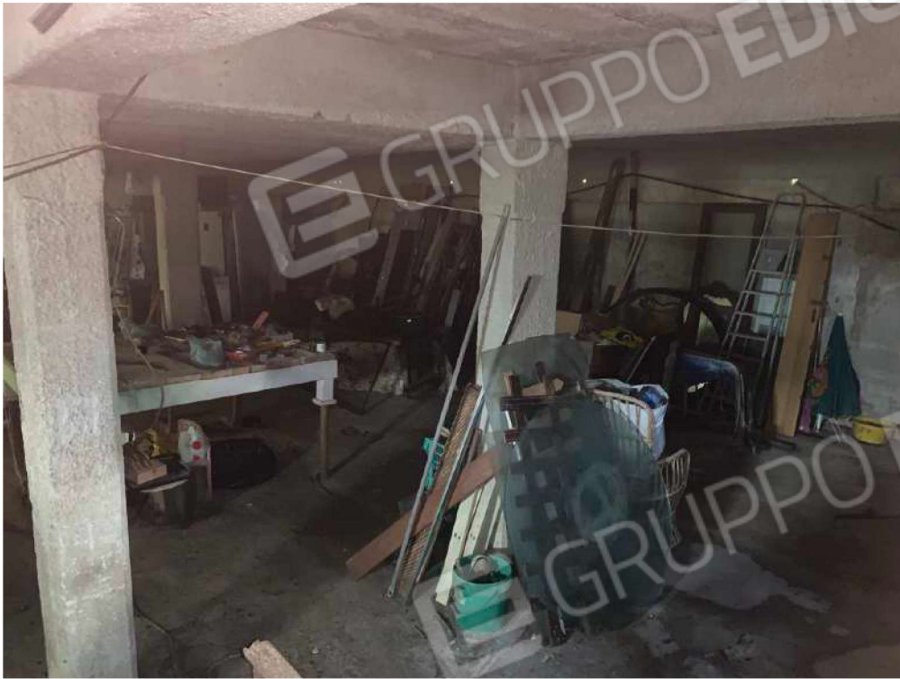
Foto n. 35 - Villa alla particella 726: Cantina
