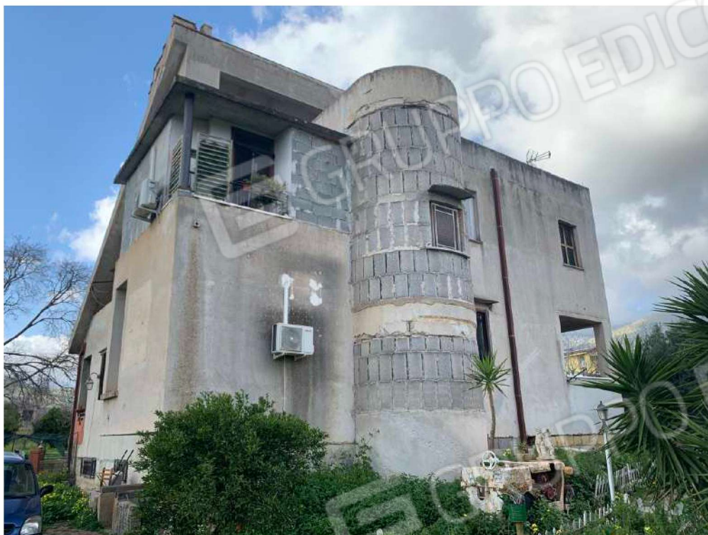
Foto n. 11 - Villa alla particella 726
