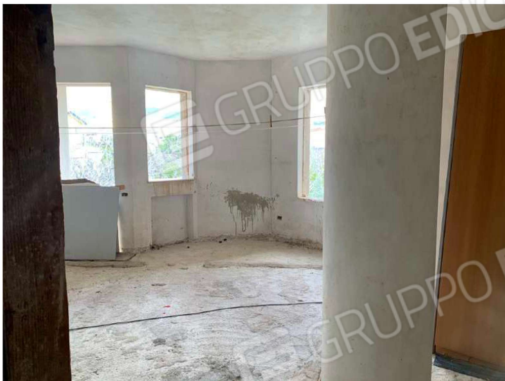
Foto n. 29 - Villa alla particella 726: Piano Primo
