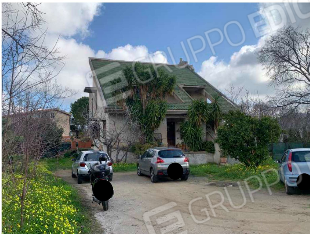
Foto n. 9 - Villa alla particella 726
