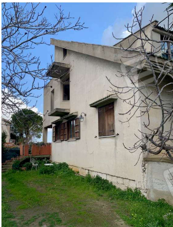
Foto n. 14 - Villa alla particella 726
