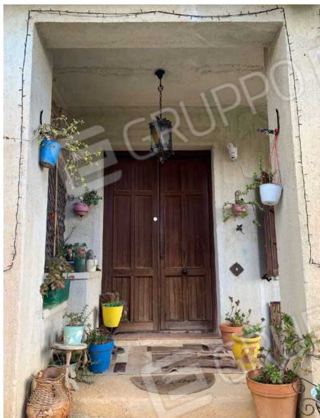
Foto n. 17 - Villa alla particella 726: Porta d'ingresso
