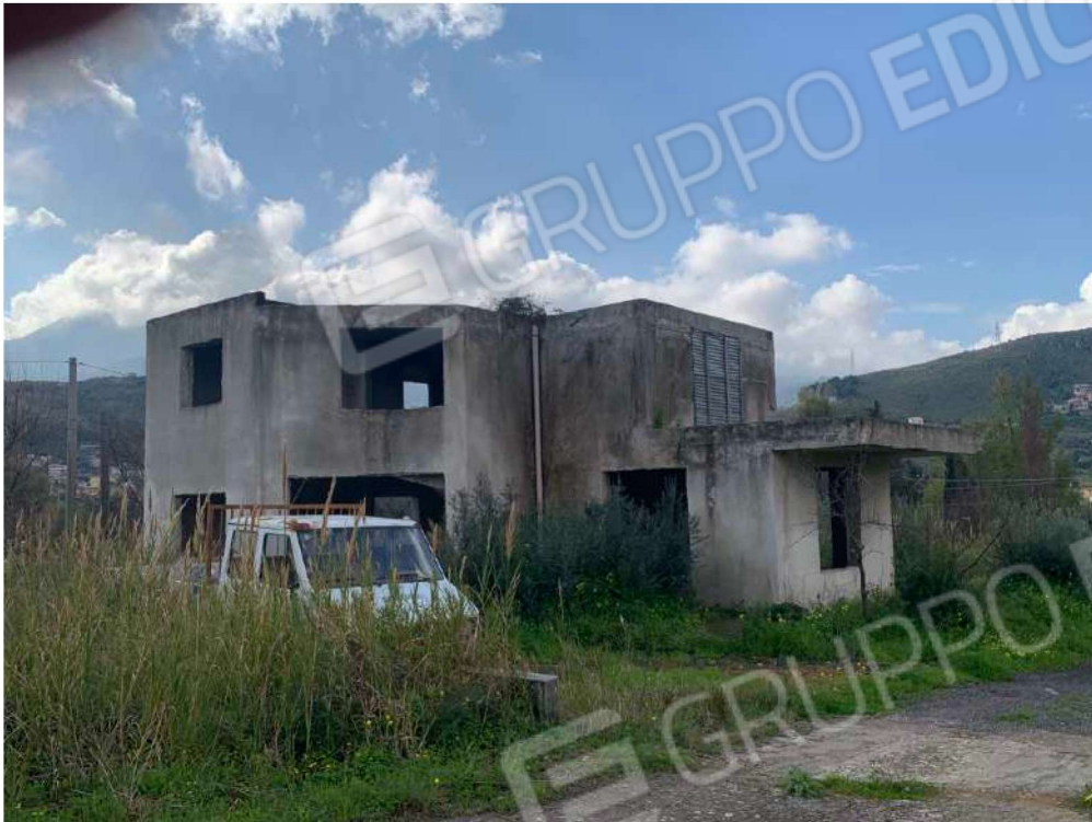
Foto n. 3 - Rudere alla particella 770
