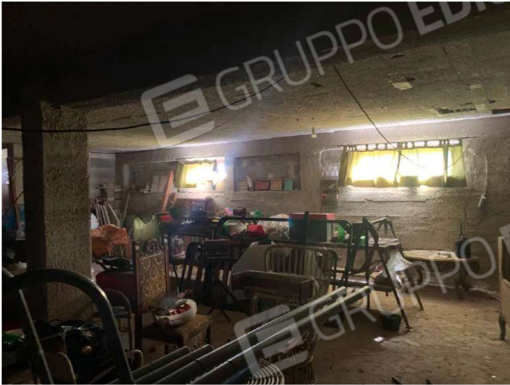
Foto n. 37 - Villa alla particella 726: Cantina
