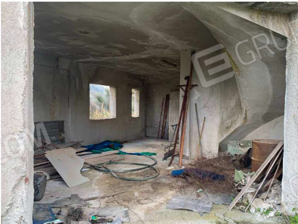
Foto n. 4 - Rudere alla particella 770
