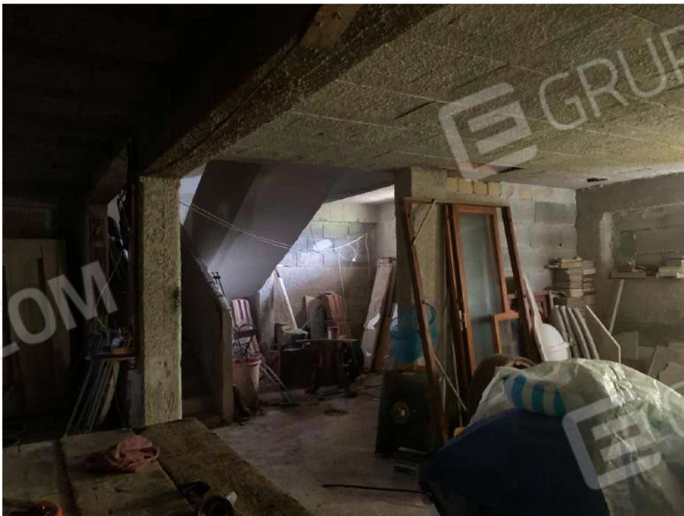
Foto n. 36 - Villa alla particella 726: Cantina
