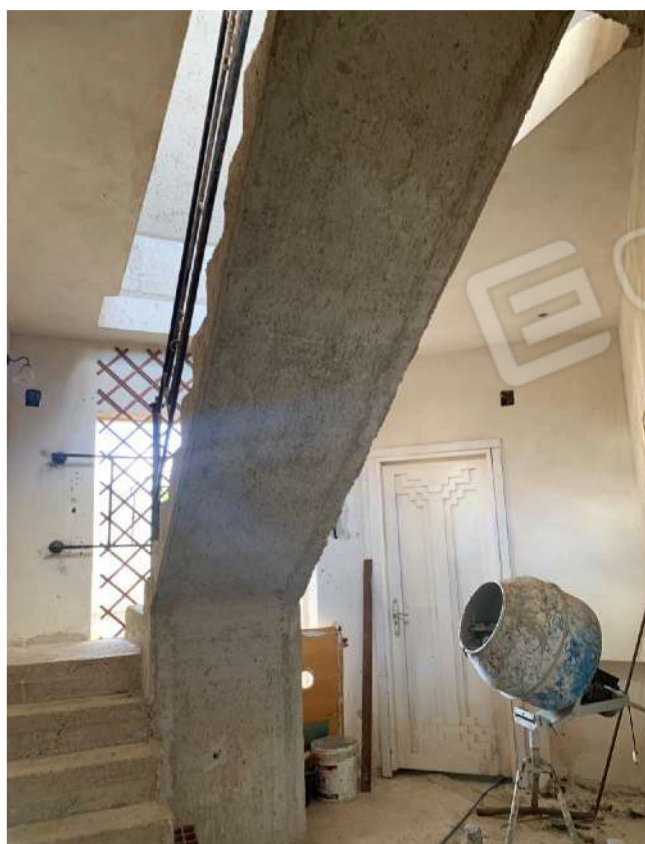
Foto n. 28 - Villa alla particella 726: piano primo
