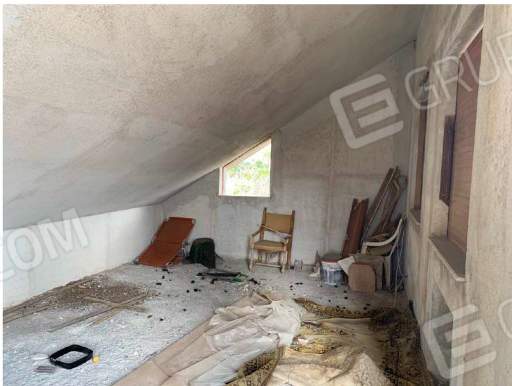
Foto n. 32 - Villa alla particella 726: Mansarda
