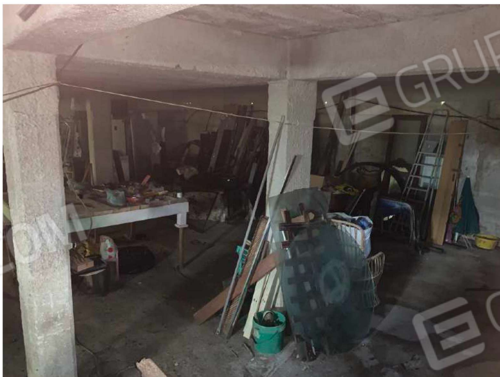
Foto n. 34 - Villa alla particella 726: Cantina
