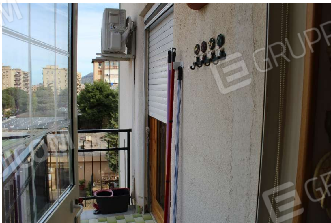
Foto n. 30 – Balcone di retro-prospetto: parte residua non chiusa a veranda
