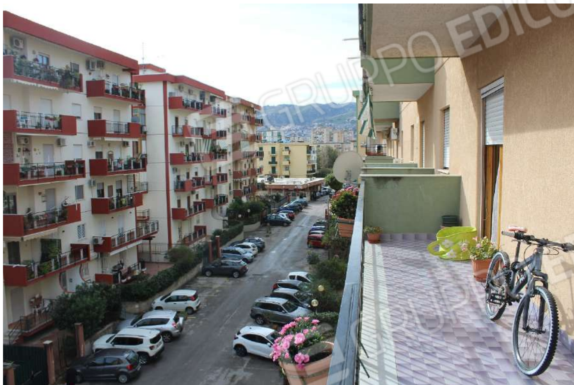
Foto n. 31 – Balcone su prospetto principale
