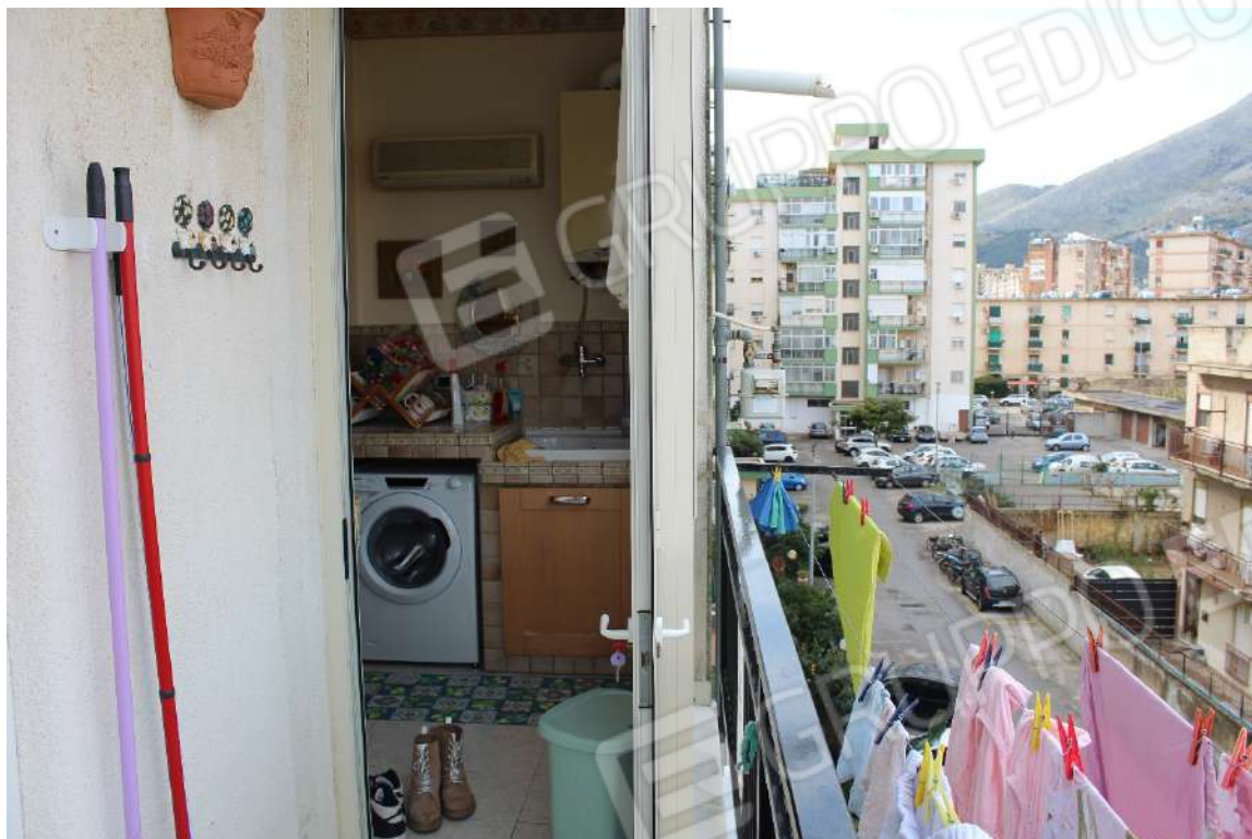
Foto n. 29 – Ampliamento (della cucina – vano 8) su balcone di retro-prospetto
