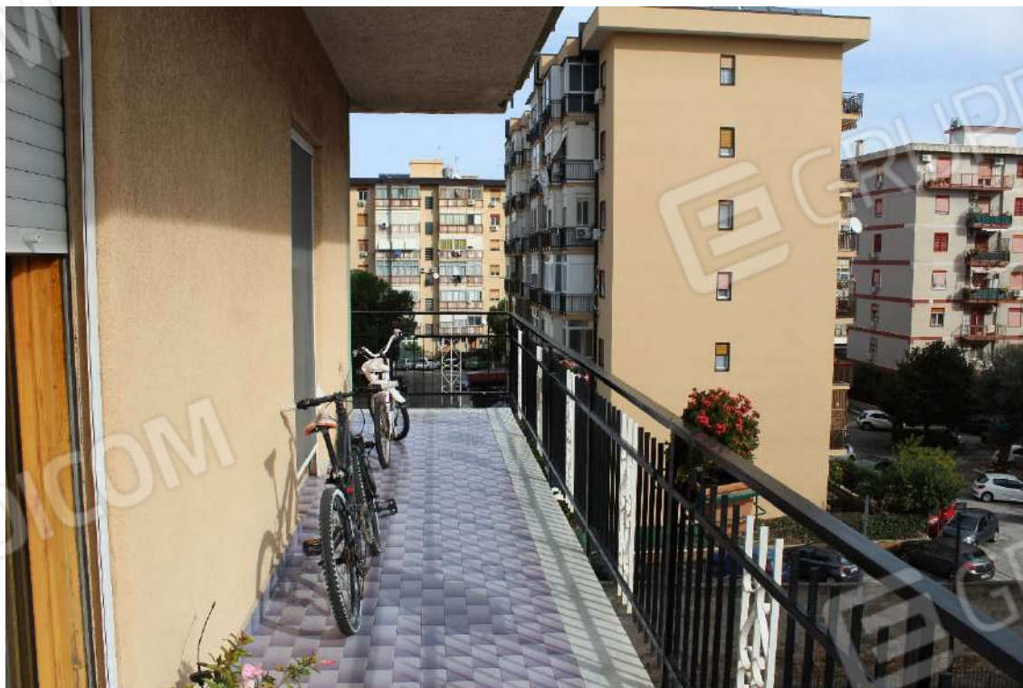
Foto n. 32 – Balcone su prospetto principale
