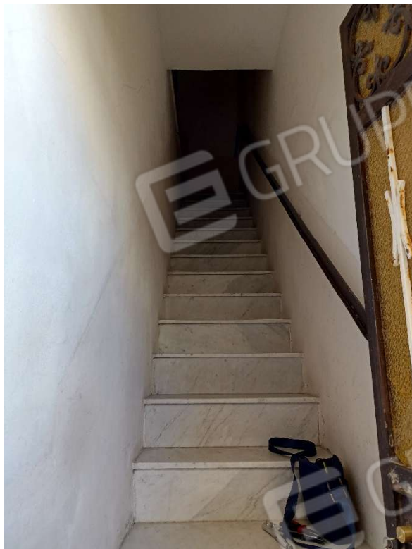
Foto n.4 – rampa vano scala dal piano terra
