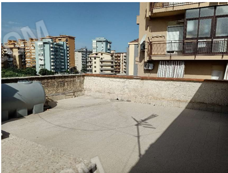
Foto n.32 – terrazzo di copertura
