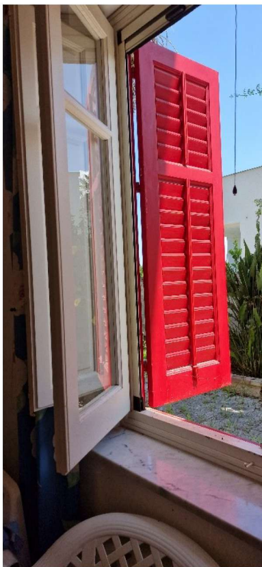
16. Particolare degli infissi.
