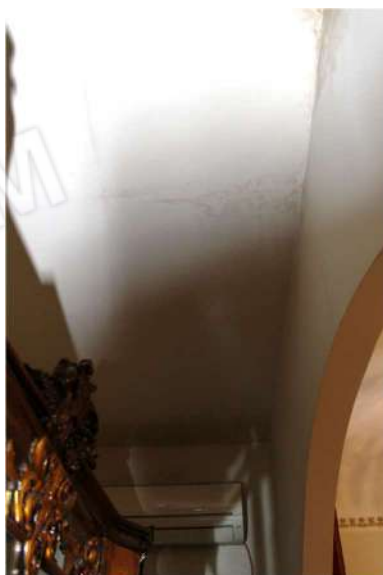
Foto nn.24, 25: Macchie da infiltrazione su intradosso solaio di copertura
