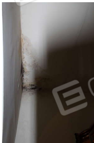
Foto nn.24, 25: Macchie da infiltrazione su intradosso solaio di copertura
