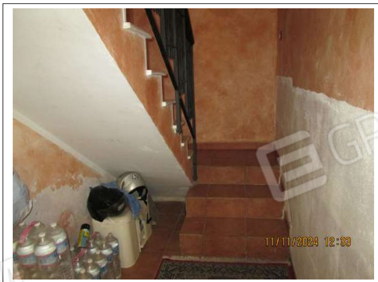
Foto n. 3-4. Scala di ingresso al piano terra
