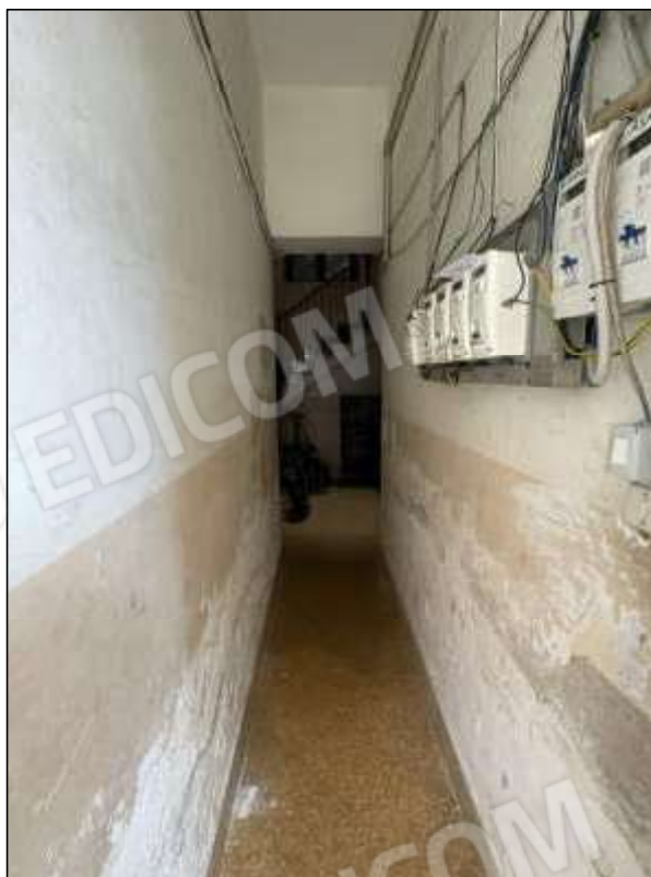
androne e vano scala
