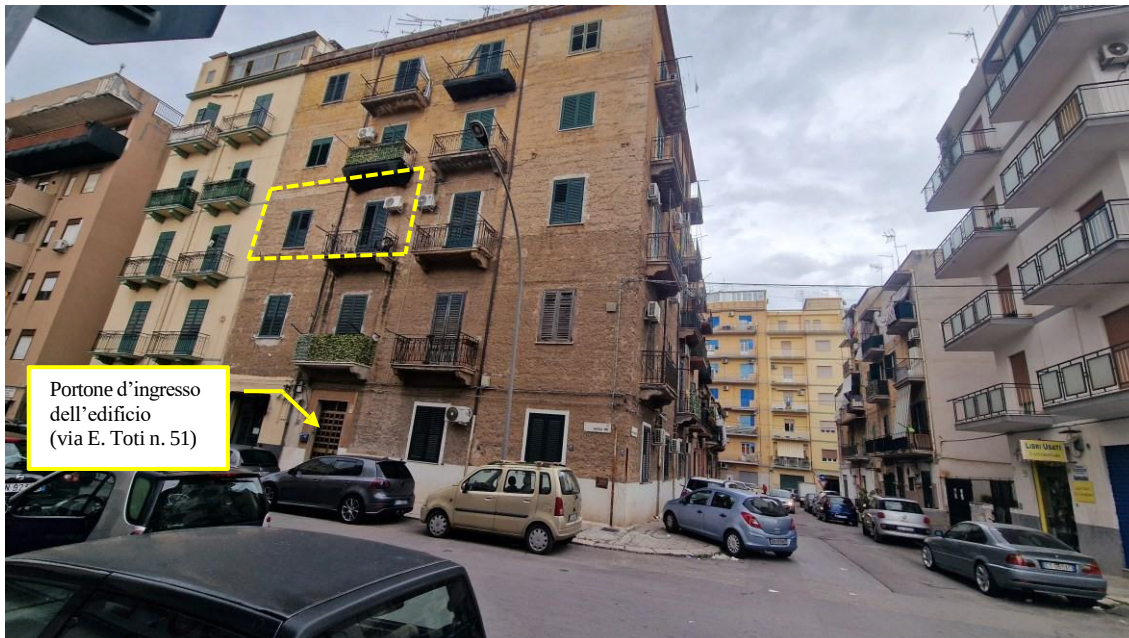
Foto 1. Vista d'angolo dell'edificio tra la via E. Toti e la via Morozzo della Rocca. In tratteggio, il bene pignorato.
