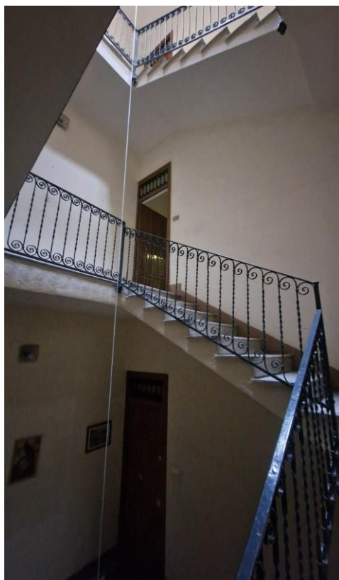
Foto 4. Vista della porta d'ingresso al piano 2°.
