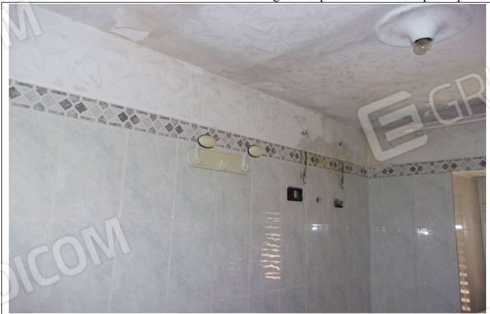
Foto n. 26 bagno al superiore ammezzato-prim piano
