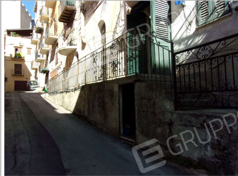
Foto n. 3 ballatoio di accesso esclusivo
