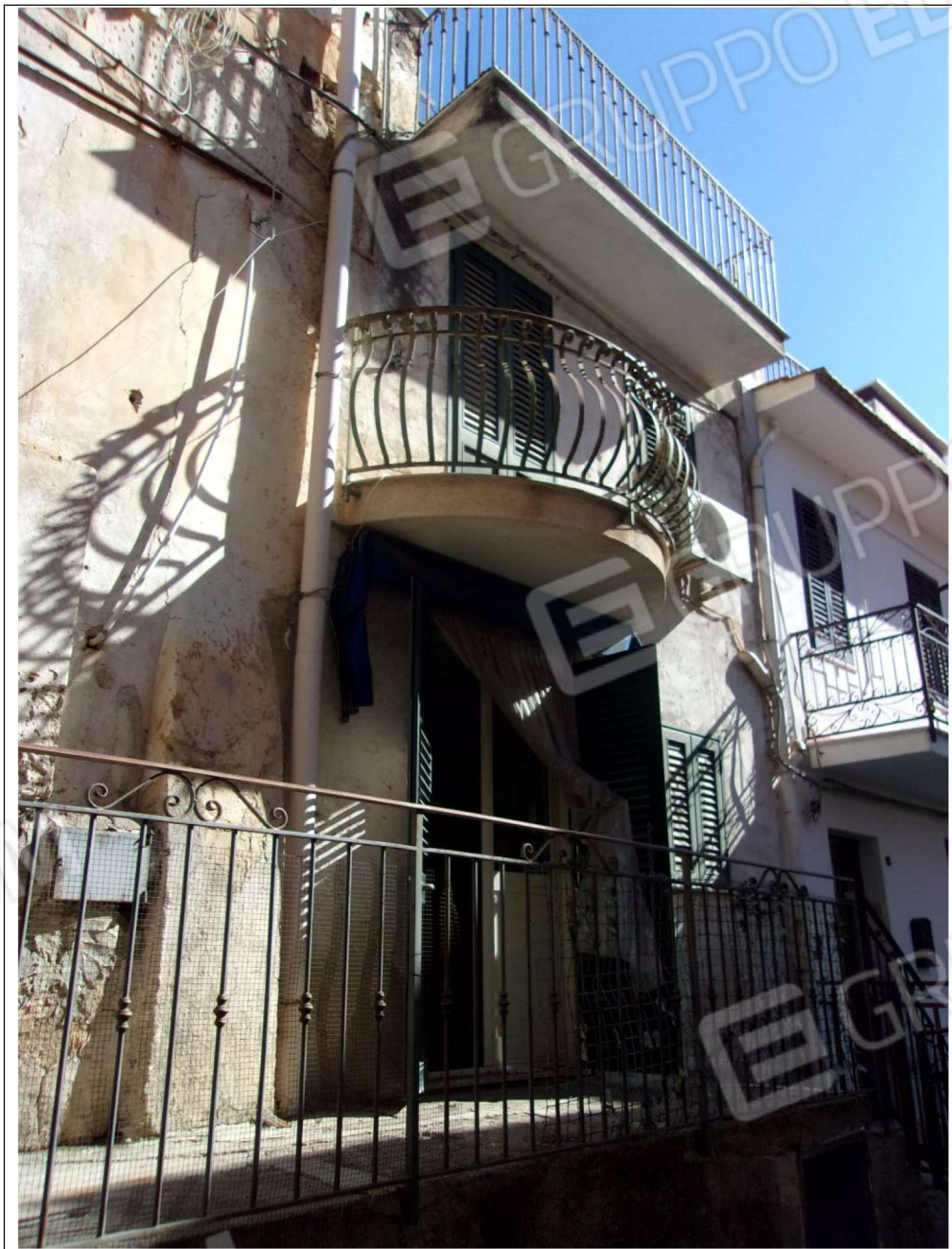
Foto n. 7 ingresso civico 13 appartamento
