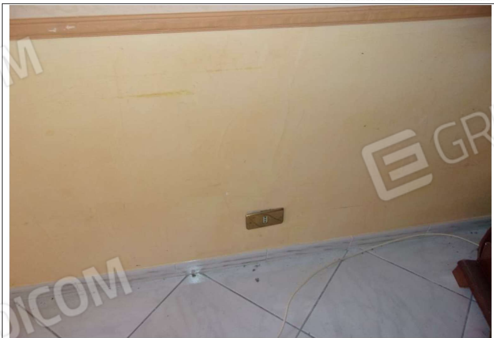
Foto n. 24 Impianto elettrico stato d'uso
