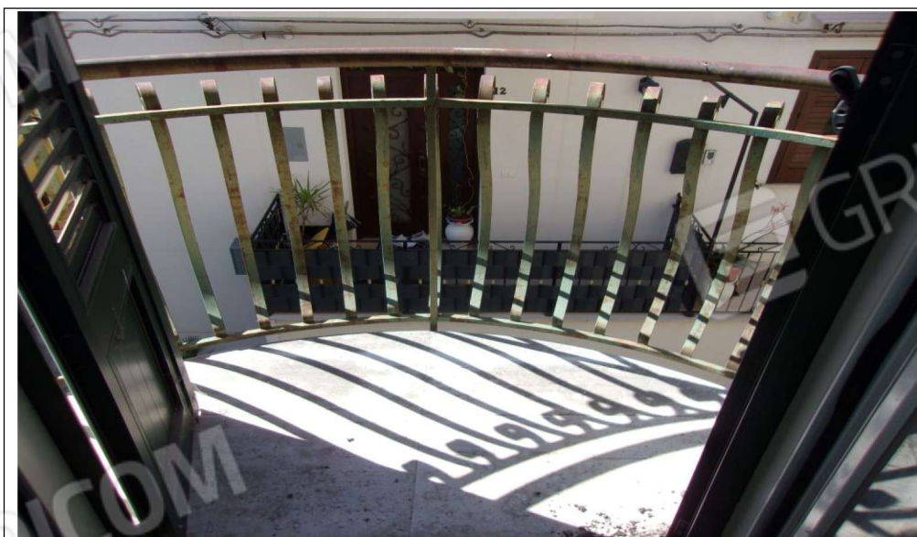
Foto n. 29 Balcone ammezzato-primo piano
