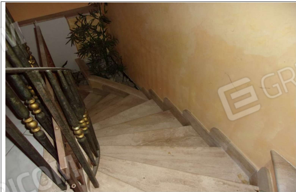
Foto n. 20 Scala di accesso al superiore ammezzato-primo piano
