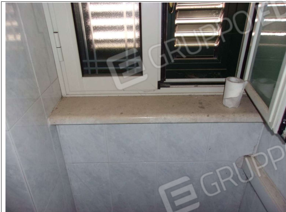
Foto n. 28 Tipologia di infissi eterni ammezzato-primo piano
