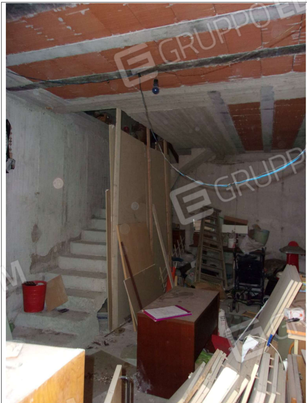
Foto n. 52 piano terra magazzino deposito
