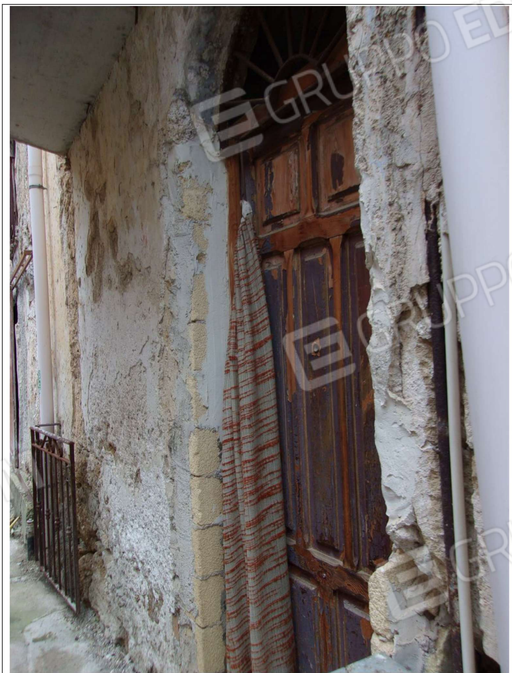
Foto n. 49 ingresso civico 9 magazzino deposito
