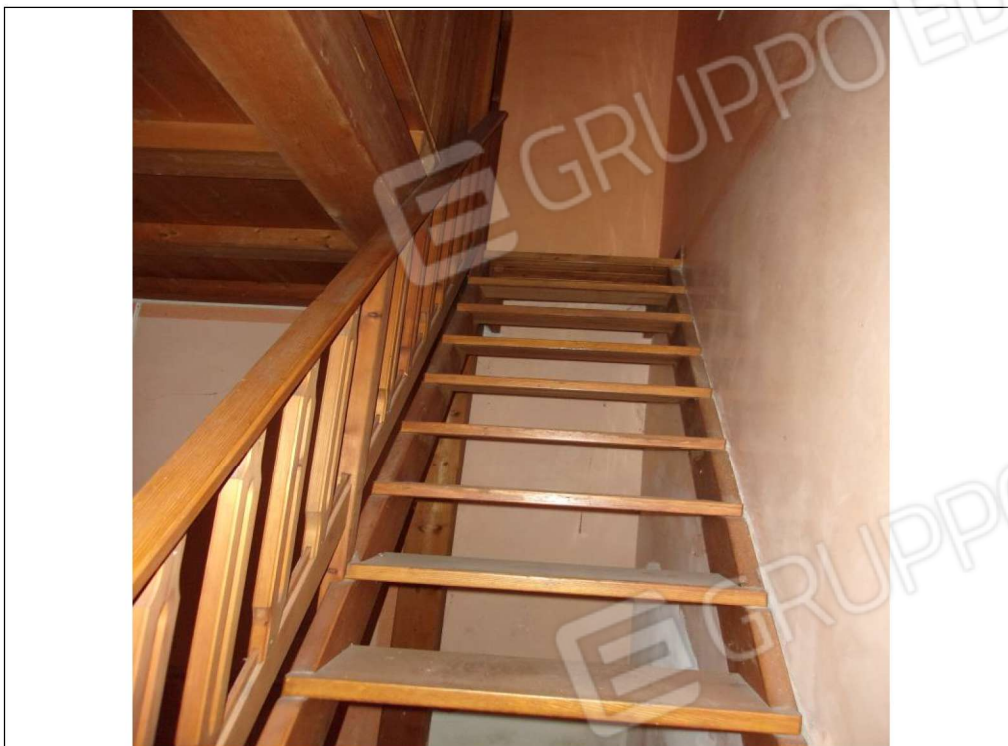
Foto n. 44 scala di accesso al soppalco
