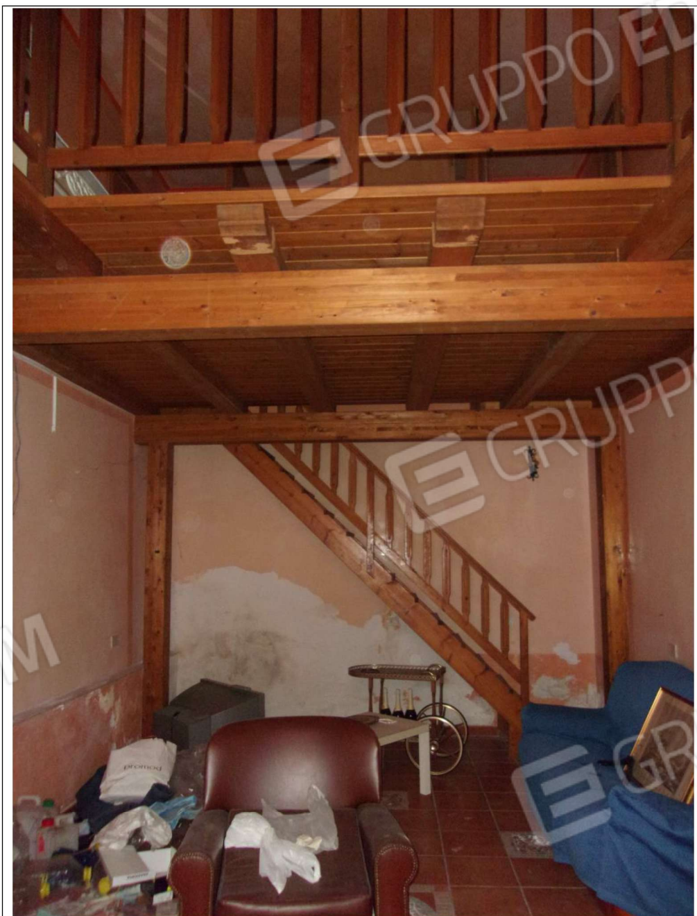
Foto n. 39 interno piano terra
