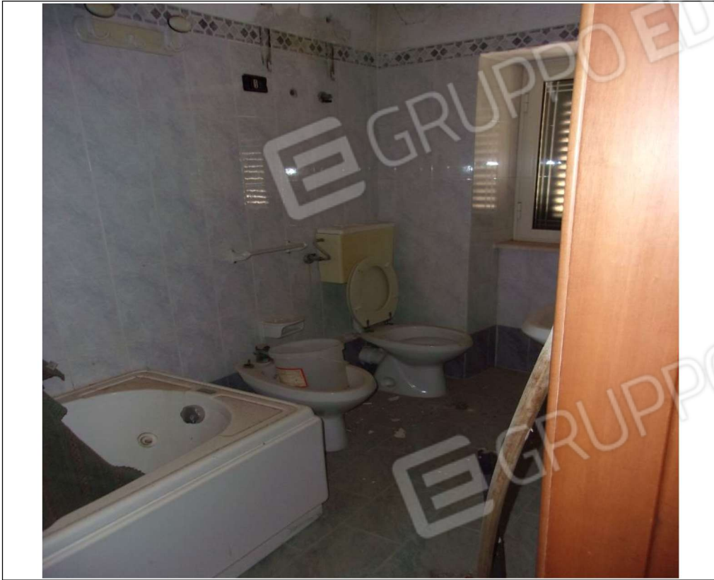
Foto n. 25 bagno al superiore ammezzato-prim piano
