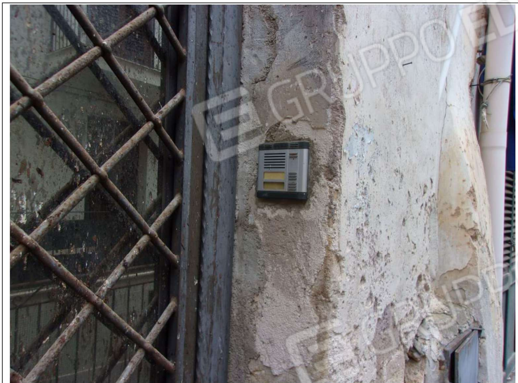
Foto n. 33 ingresso civico 11 appartamento
