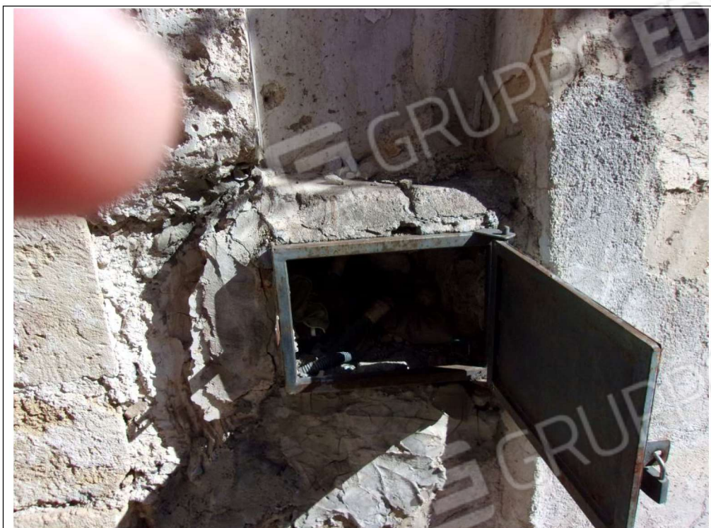
Foto 5 predisposizione contatore idrico
