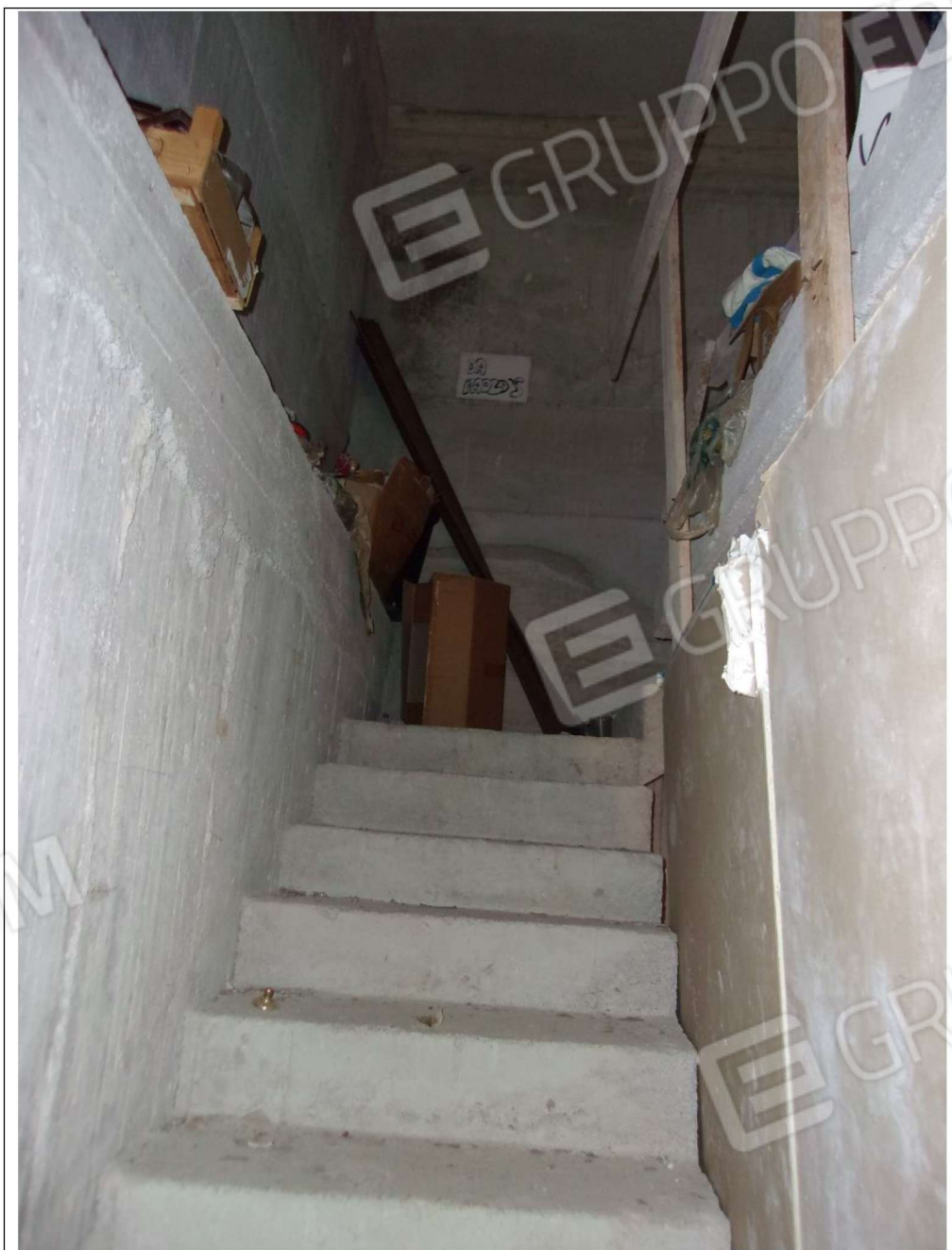
Foto n. 53 scala di accesso al piano superiore
