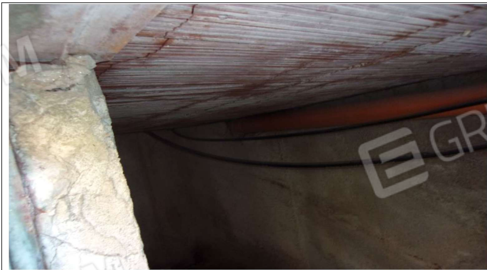
Foto n. 4 interno del ballatoio esclusivo di accesso in cui passano gli scarichi dell'immobile e le linee di allaccio idrico
