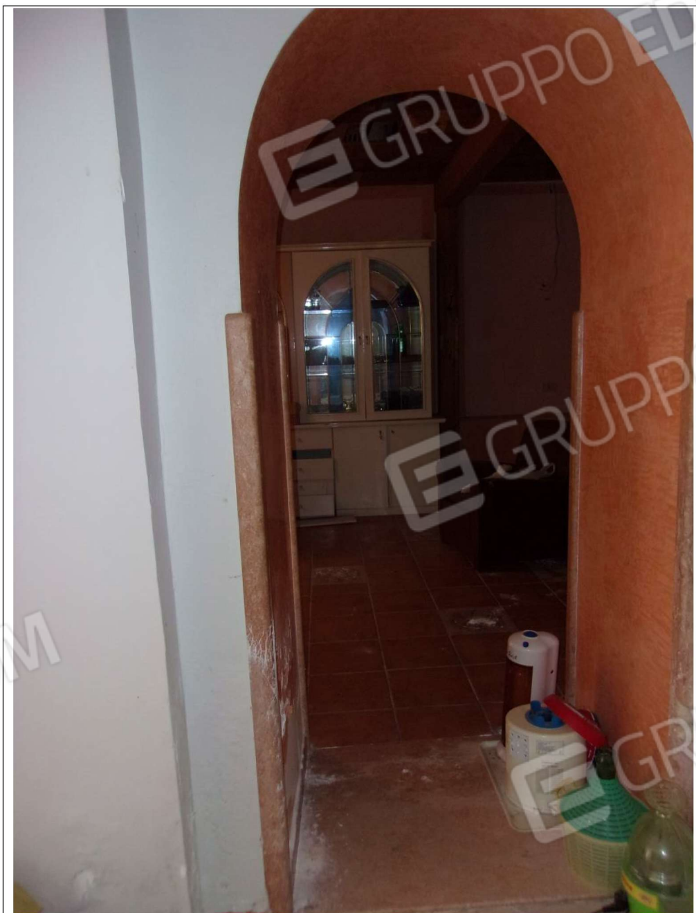
Foto n. 35 varco di accesso dall'adiacente civico 13 (cucina soggiorno)
