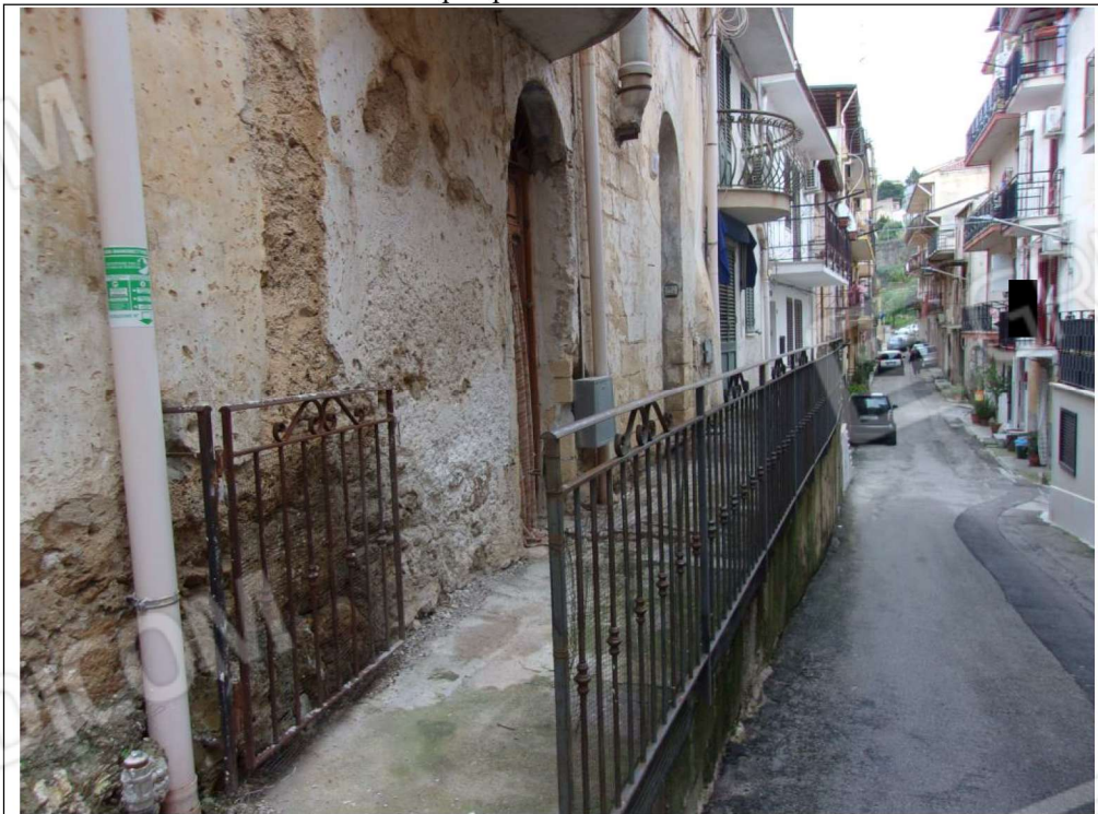
Foto n. 2 ballatoio di accesso esclusivo
