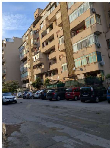
Foto 1: prospetto su via Cartagine
