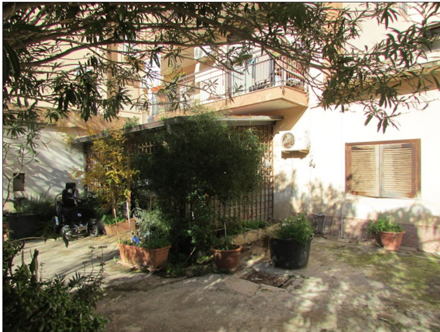
Figura 7: Particolare del retroprospetto dell'edificio in corrispondenza dell'immobile pignorato, al piano terra
