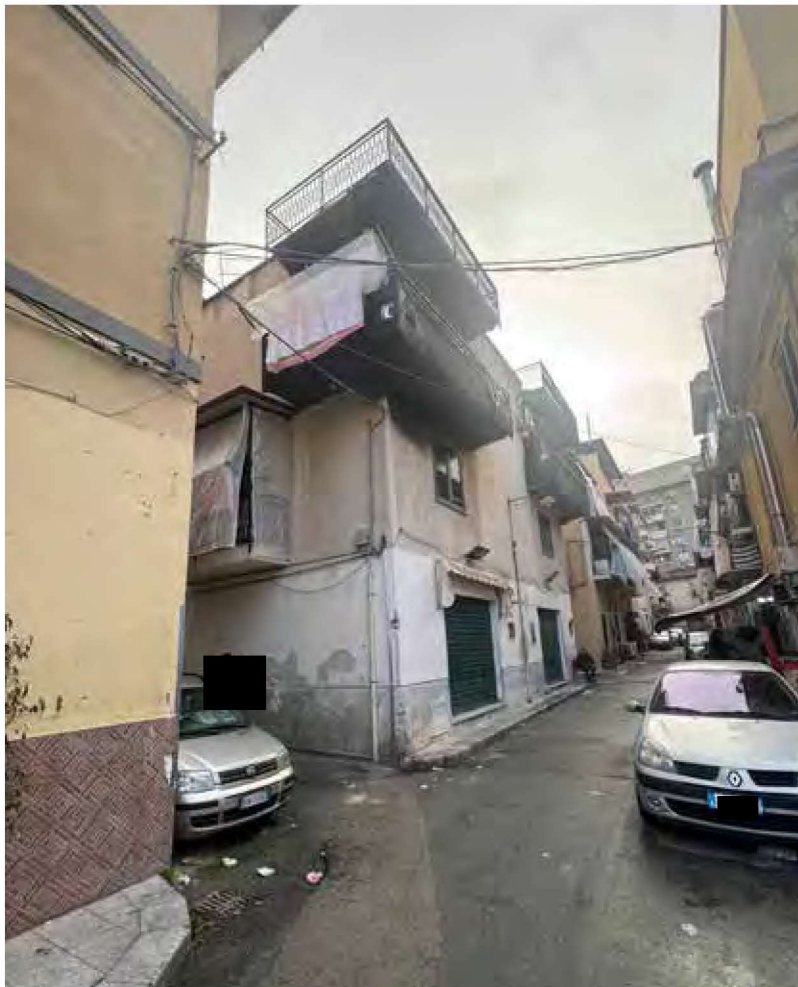
Foto n. 1: La palazzina, angolo tra via Anime Sante e via Borgo Nuovo..
