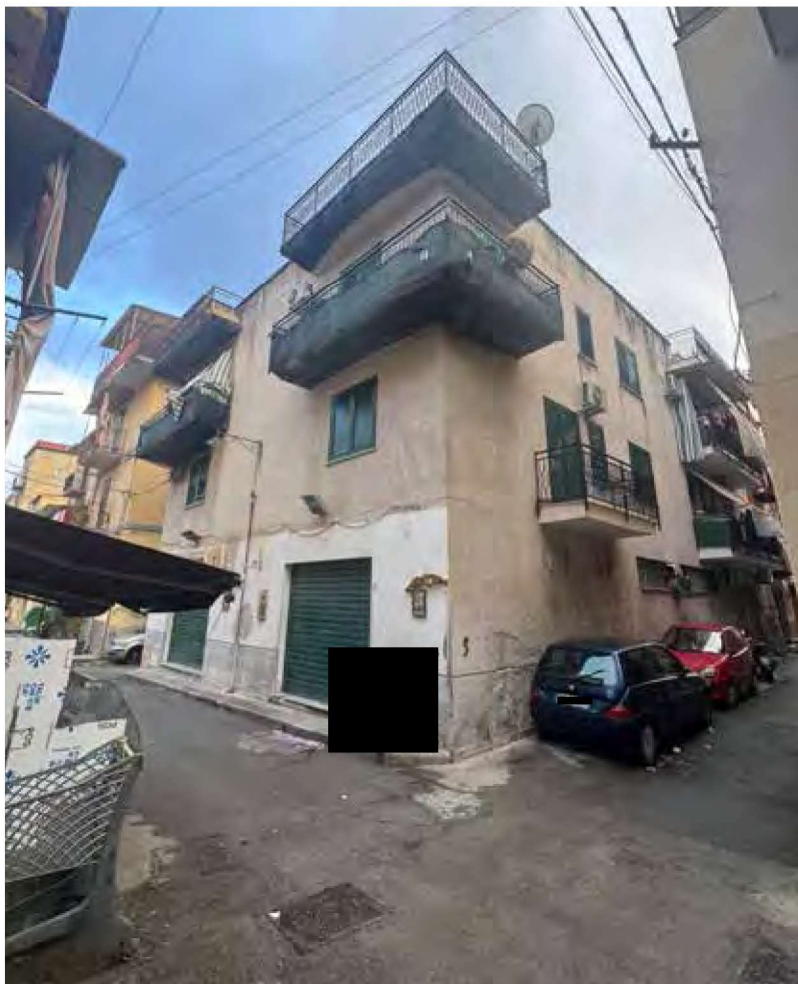
Foto n. 2: La palazzina, angolo tra via Borgo Nuovo e vicolo Forno al Borgo..
