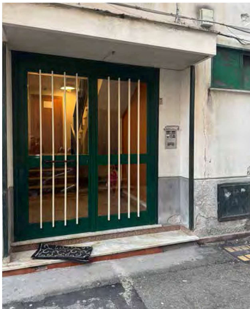
Foto n. 4: Il portone di ingresso alla palazzina.
