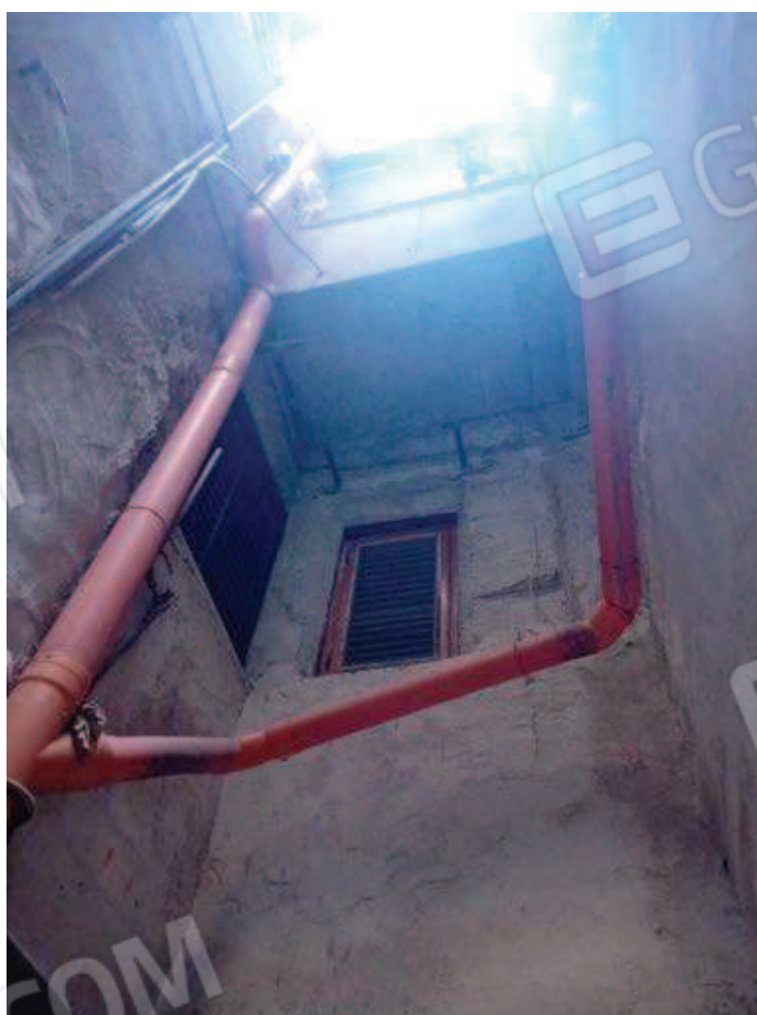
Foto 16- vista interna del pozzo luce del fabbricato
