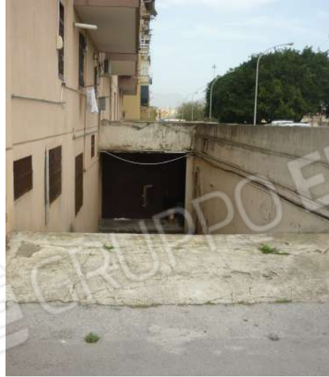
Foto n. 2 – Scivolo di accesso al locale
