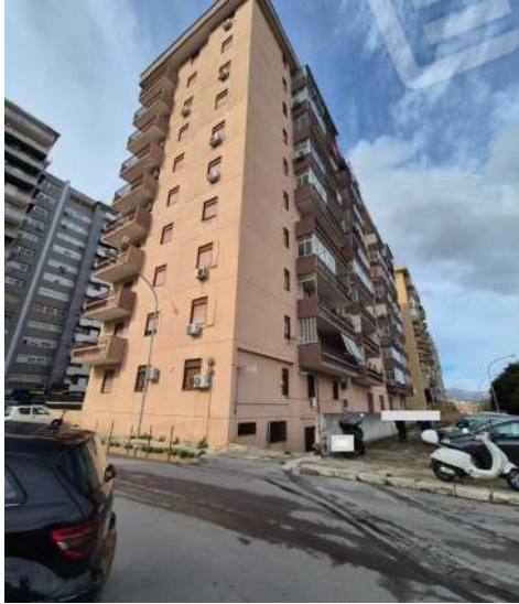
Foto n. 1 – Vista dalla via A. Biondo
