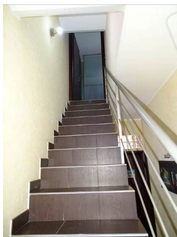
Foto n. 24 P.2 - Scala interna
