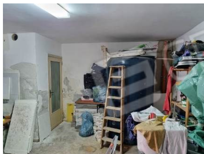
Foto n. 39 P.T. - Locale Box.
