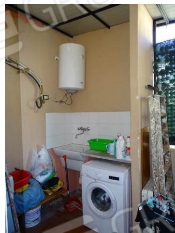
Foto n. 34 P.3 - Terrazzo (zona lavanderia).
