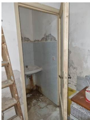
Foto n. 41 P.T. - Locale wc nel Locale Box.
