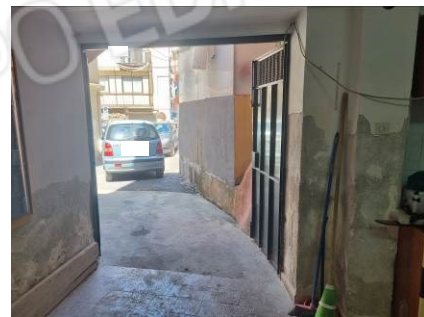
Foto n. 37 P.T. - Locale Box.
