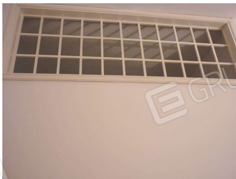
FOTO 12 VANO LUCE SU VANO FINISTRATO
