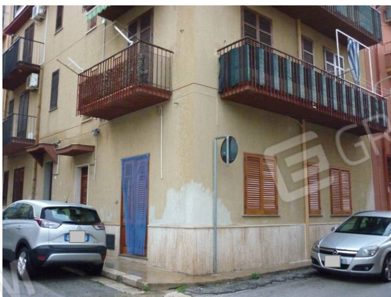
FOTO 6 INGRESSO IMMOBILE VIA IV NOVEMBRE 81
