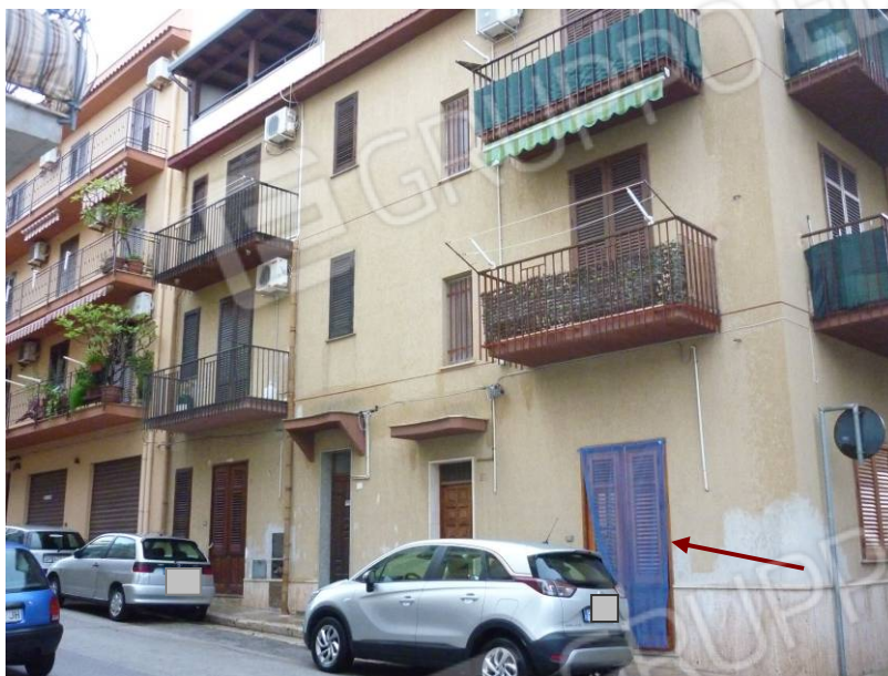
FOTO 5 INGRESSO IMMOBILE VIA IV NOVEMBRE 81
