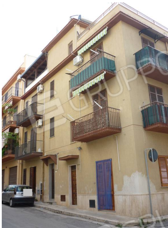
FOTO 3 EDIFICIO VIA IV NOVEMBRE
