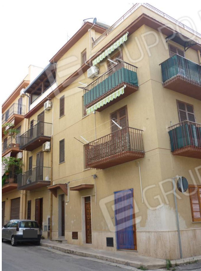
FOTO 3 EDIFICIO VIA IV NOVEMBRE
