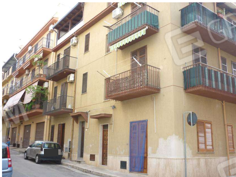
FOTO 4 EDIFICIO VIA IV NOVEMBRE
