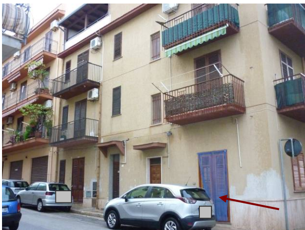
FOTO 5 INGRESSO IMMOBILE VIA IV NOVEMBRE 81
