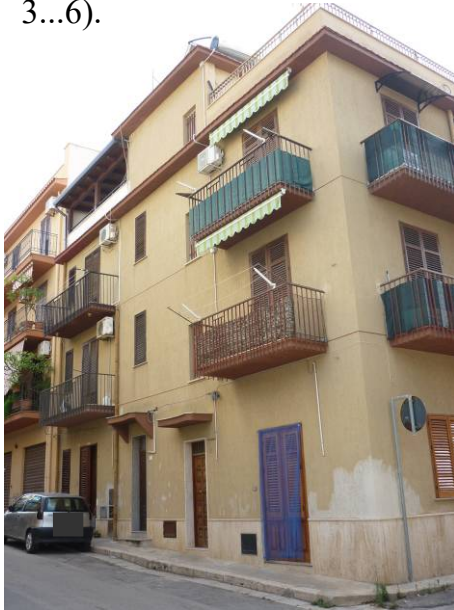
FOTO 3 EDIFICIO VIA IV NOVEMBRE
