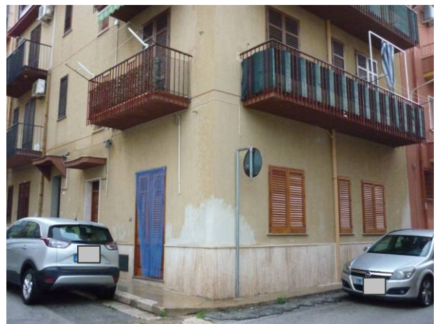
FOTO 6 INGRESSO IMMOBILE VIA IV NOVEMBRE 81
