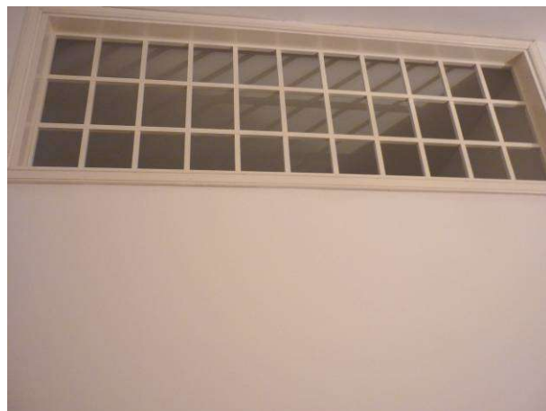
FOTO 12 VANO LUCE SU VANO FINESTRATO
