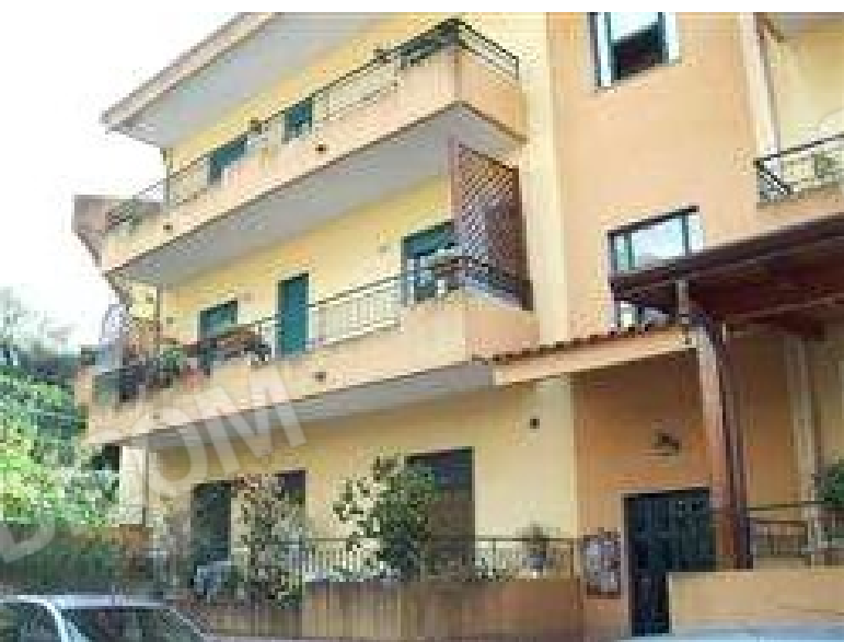
Foto n. 1 prospetto lato est fabbricato Via Garibaldi
