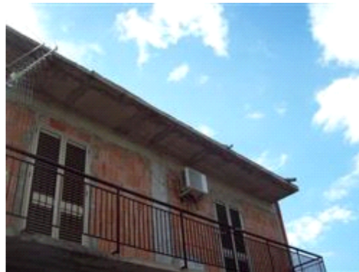
Foto n. 9 appartamento al primo piano lato nord
