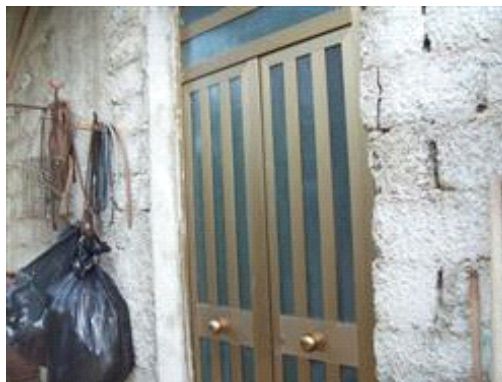
Foto n.2 ingresso pedonale lato nord
