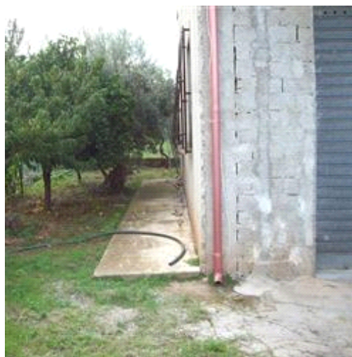
Foto n. 3 parte del giardino ingresso carrabile lato est
