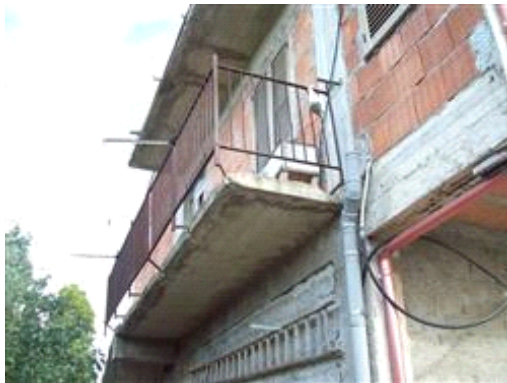
Foto n. 8 appartamento al primo piano lato est
