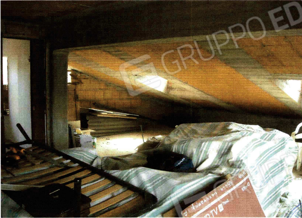
FOTO N. 3 – INTERNO SOTTOFALDA LATO SUD
