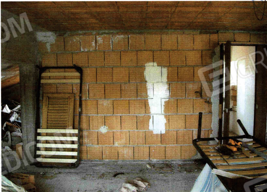
FOTO N. 4 – INTERNO SOTTOTETTO E PORTA DI INGRESSO
