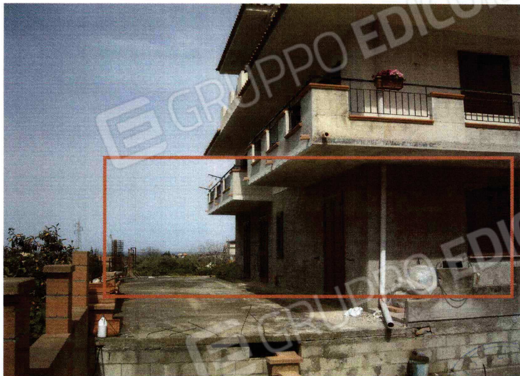
FOTO N. 3 - PIANO TERRA PROSPETTO OVEST - CONTORNATO
