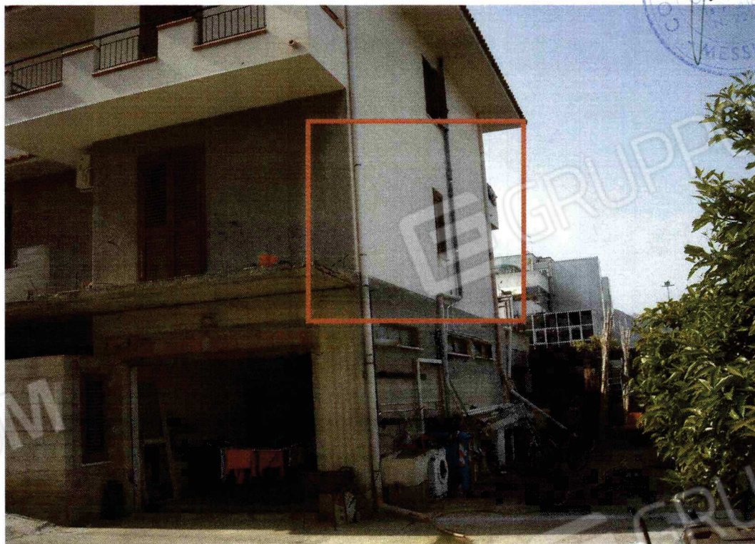
FOTO N. 4 - PIANO TERRA PROSPETTO NORD - CONTORNATO
