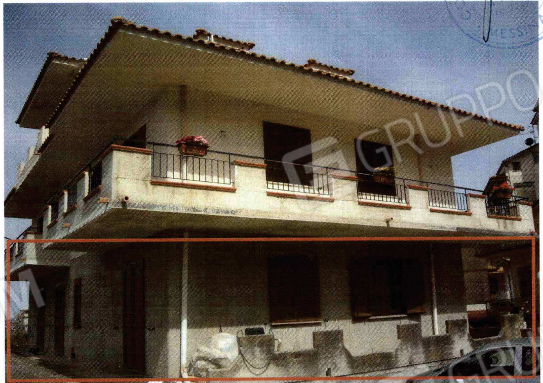
FOTO N. 2 - PIANO TERRA PROSPETTO EST - CONTORNATO
