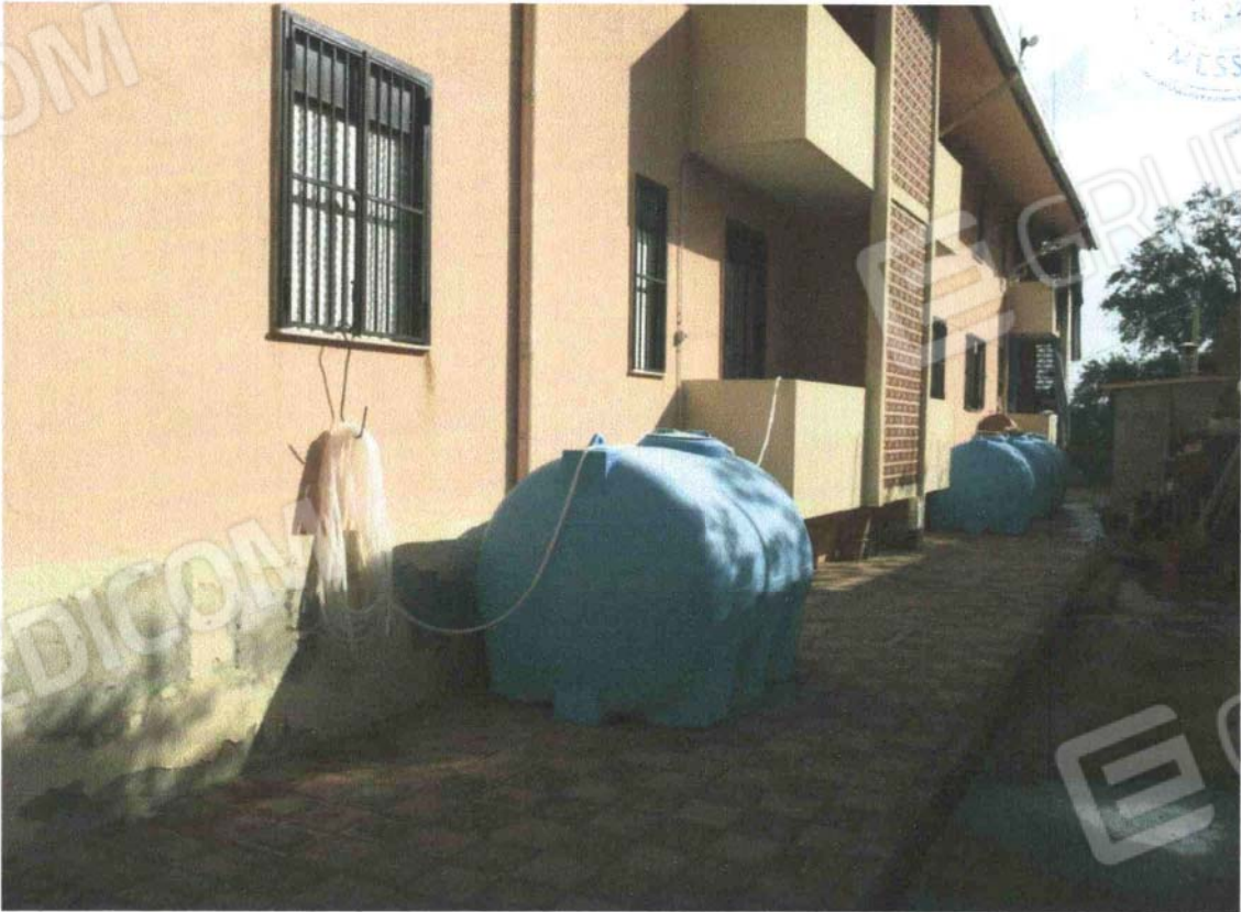
FOTO N° 4 PROSPETTO SUD - LOTTO 1 SUBB 7 - 8
