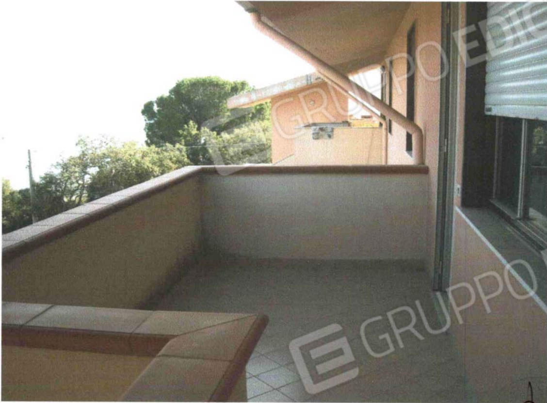
FOTO N° 13 TERRAZZINO DI INGRESSO - SUB 8
