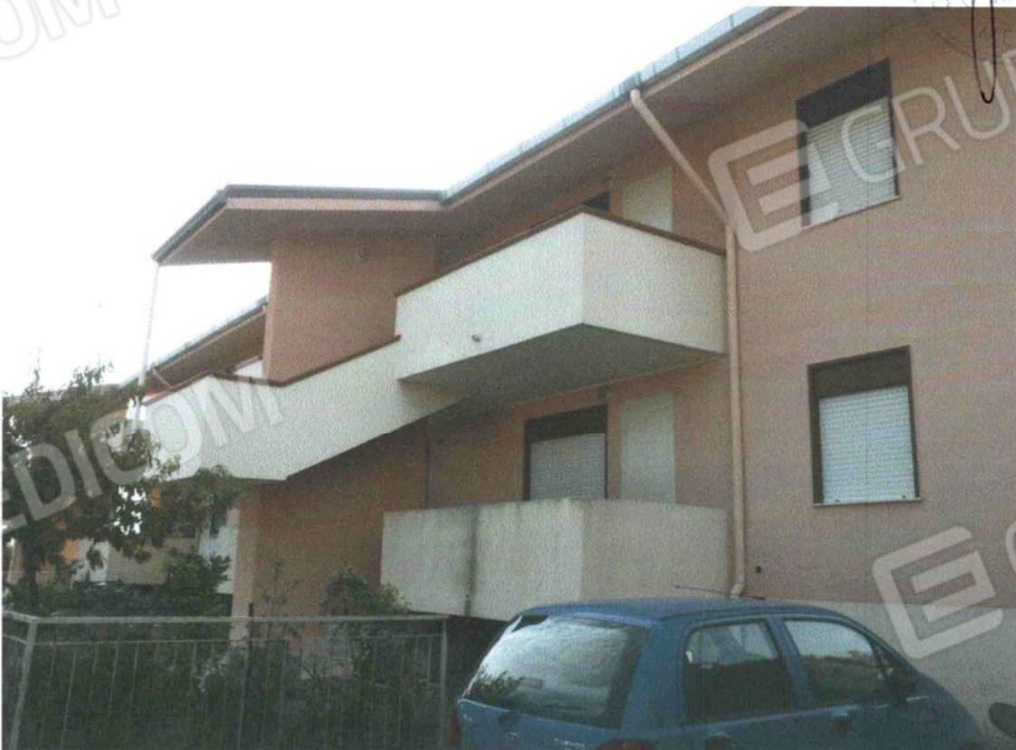
FOTO N° 2 PROSPETTO LATO NORD - LOTTO 1 SUBB 7 - 8
