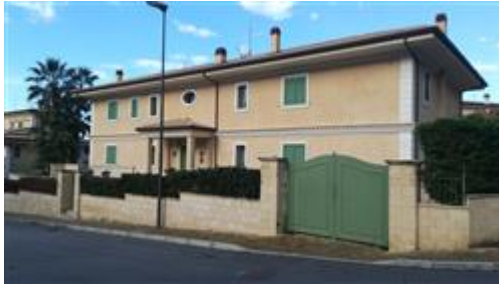
Vista dell'intero fabbricato.
