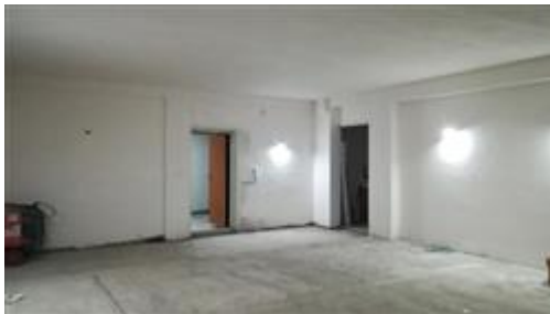
Ambiente al piano seminterrato.
