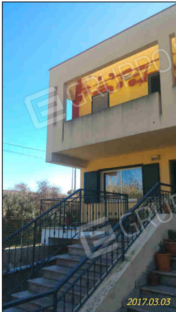
Foto n. 3 – Unità immobiliare oggetto della presente procedura – prospetto principale
