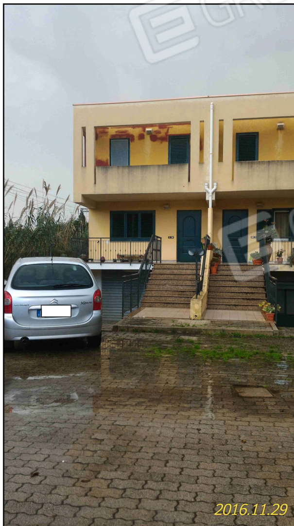
Foto n. 2 – Unità immobiliare oggetto della presente procedura – prospetto principale
