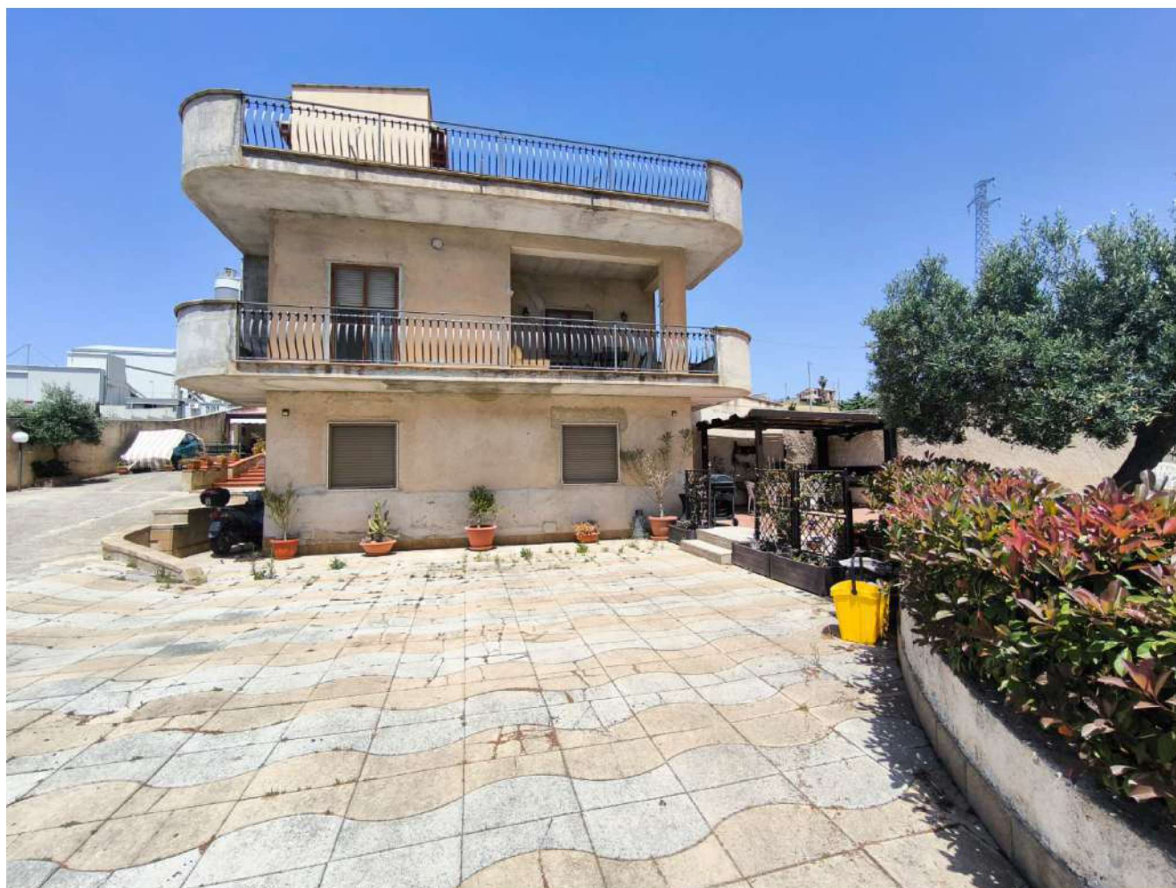
Prospetto Fabbricato Via Lioni
